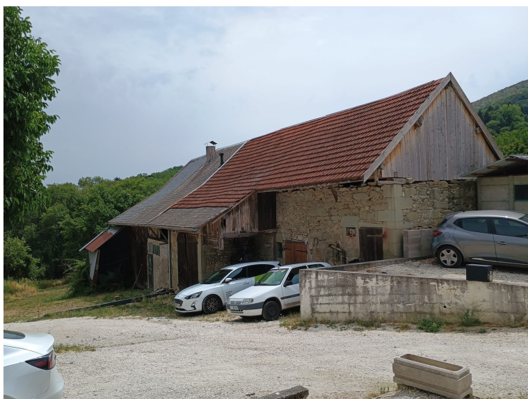
Façade du bâtiment, en pierre traditionnelle.
