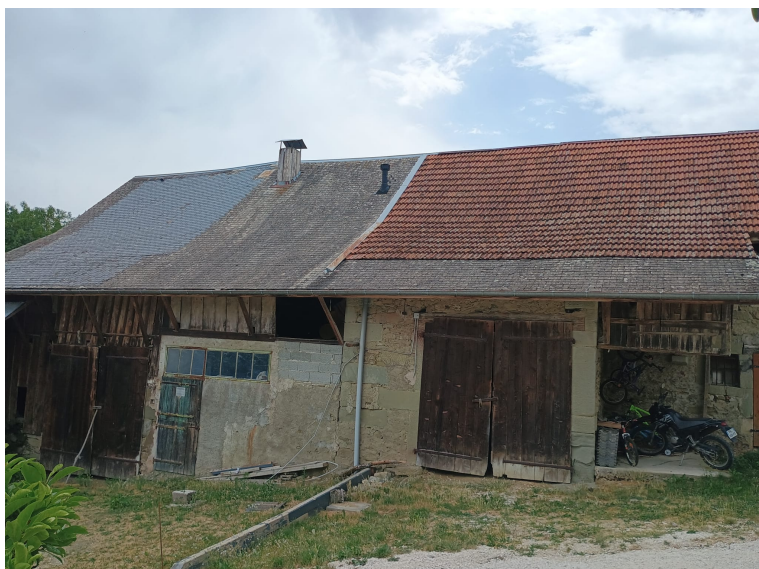
Vue détaillée de la façade et des ouvertures existantes.
