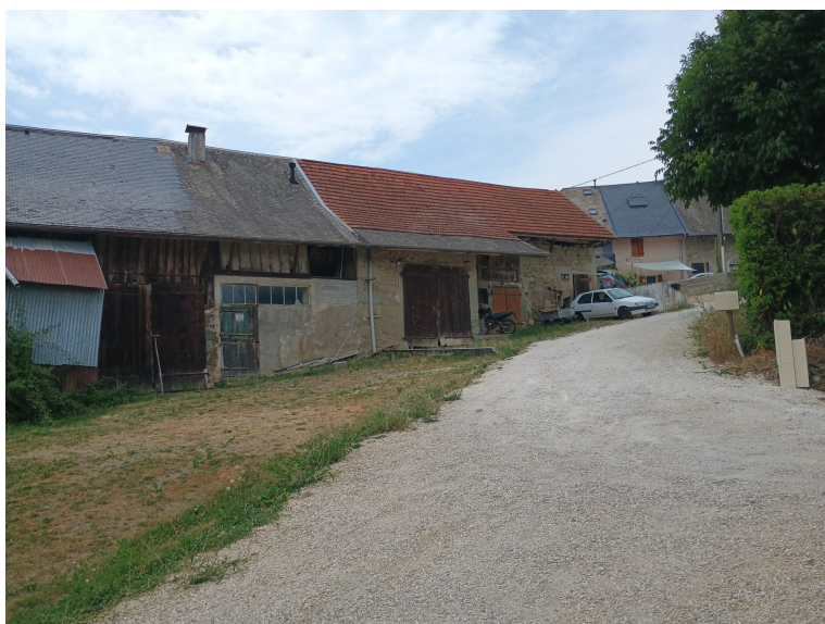
Chemin d'accès carrossable desservant le bâtiment, avec espace de stationnement.
