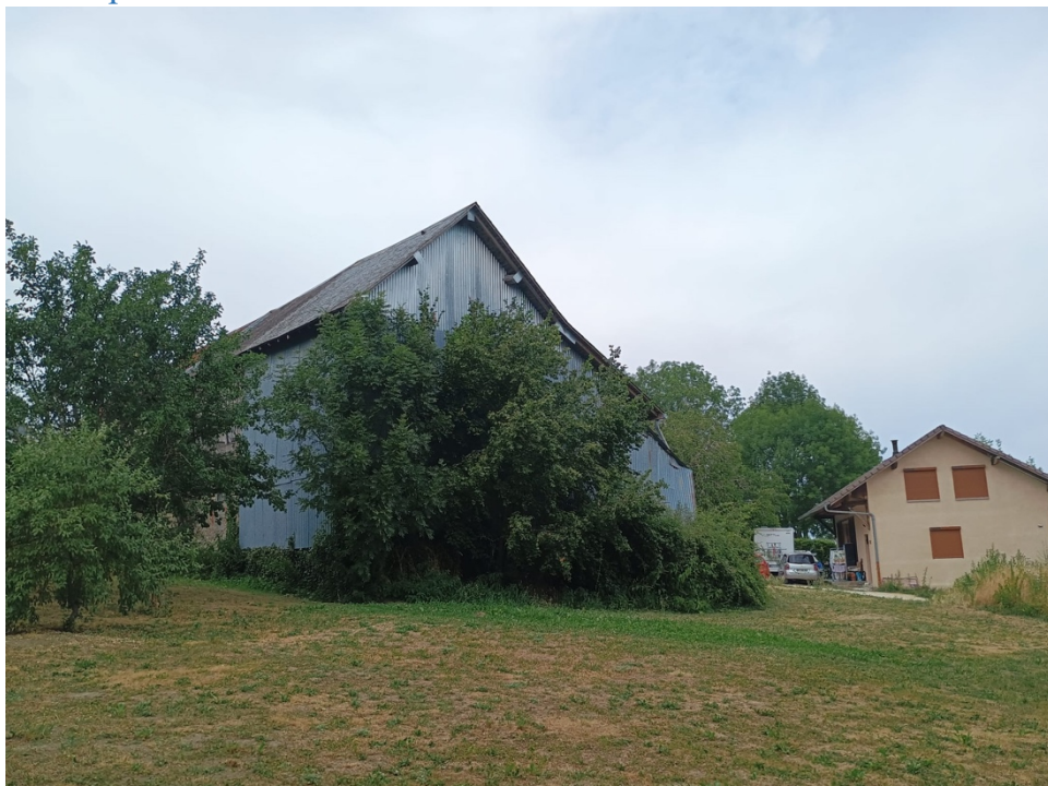
Annexe 4 – Vu partie basse du bâtiment
