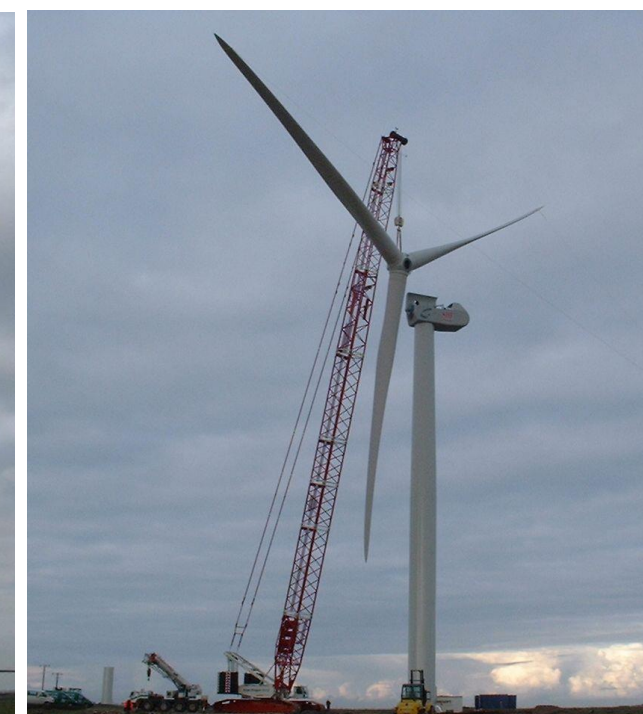
Montage du rotor
