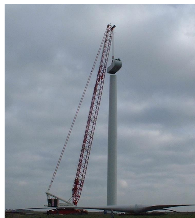
Montage de la nacelle
