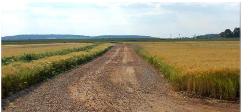
Photo 3 : Exemple de voie d'accès à un parc éolien
