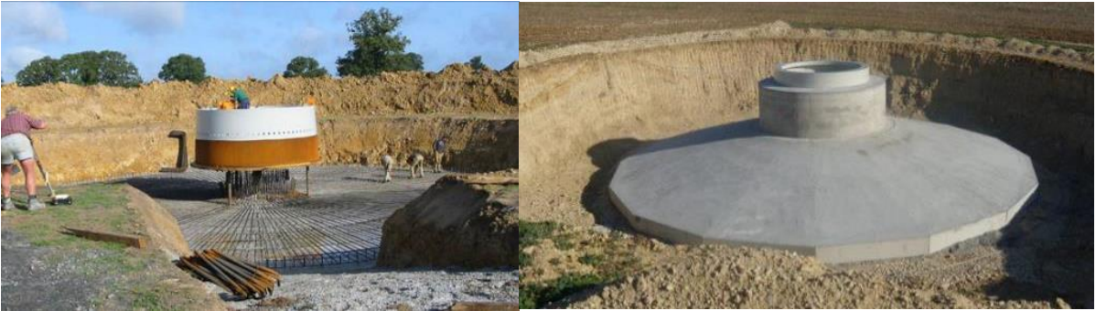
Photo 2 : Le ferrailage et le coulage d'une fondation d'éolienne
