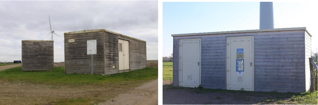
Photo 4 : Exemples de poste de livraison électrique
