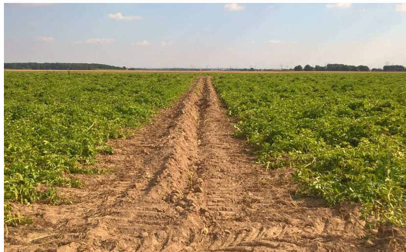
Photo 112 : Tranchée pour le passage de réseau électrique HTA à partir d'un soc tracté (Source : VALOREM)
