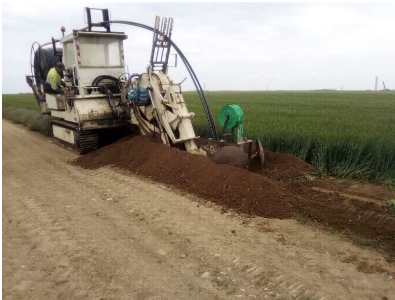
Figure 52 : Pose d'un câble HTA à 1,20 m avec la méthode du soc tracté (Source : VALOREM)
