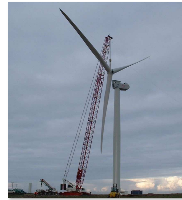
Photo 121 : Mise en place du rotor tripale (Source : VALOREM)
