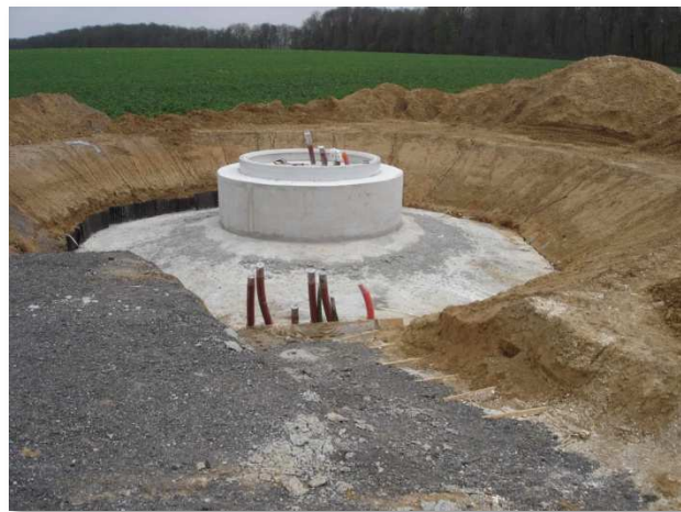
Photo 115 : Béton terminé (Source : VALOREM)
