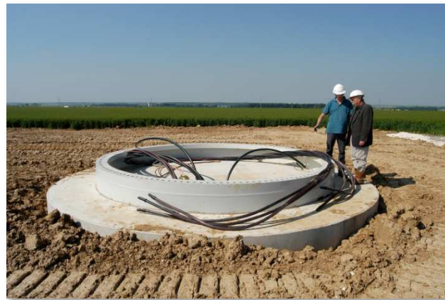
Photo 116 : Fondation terminée (Source : VALOREM)
