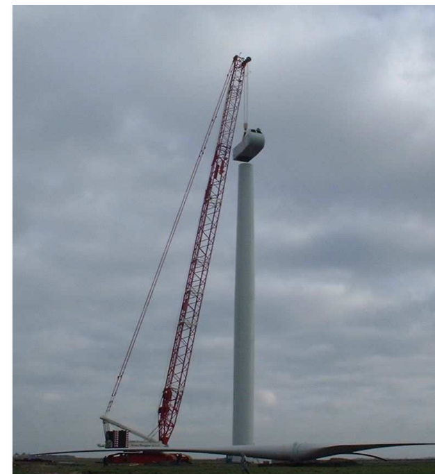
Photo 120 : Installation de la nacelle (Source : VALOREM)
