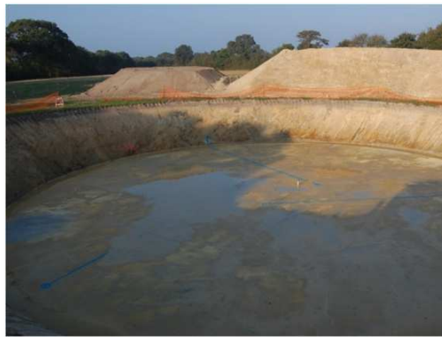
Photo 113 : Excavation (Source : VALOREM)
