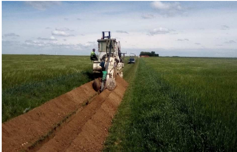
Photo 111 : Tranchée pour le passage de réseau électrique HTA à partir d'une trancheuse (Source : VALOREM)
