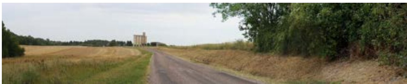
Photo 23 : Depuis l'entrée sud du bourg de Trouans sur la RD 9, la présence d'une ligne de crête et de la masses arborées réduisent les vues sur la Zone d'Implantation Potentielle. Toutefois, dans l'axe de la route, le parc de Lhuître est perceptible
