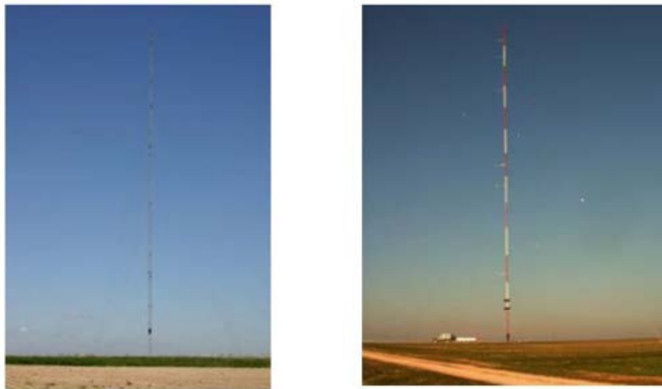
Photo 3 : Mâts de mesure installés sur le site (40 m à gauche, 80 m à droite). Source : VALOREM
