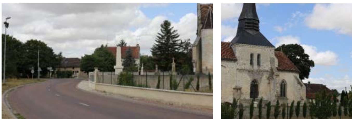
Photo 38 : Depuis les abords de l'église de Venet, la Zone d'Implantation Potentielle est perceptible, comme en témoigne l'éolienne du parc de Lhuître perceptible sur la droite
