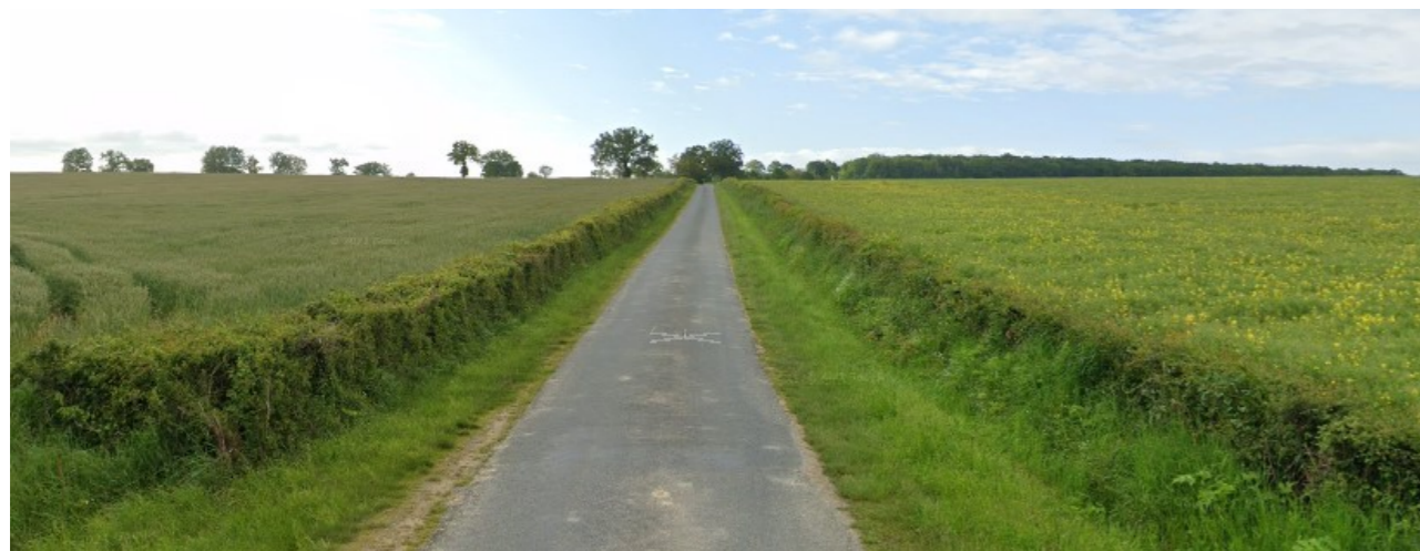
Figure 23 - Allée de Barassier (accès aux éoliennes 1 à 4)
