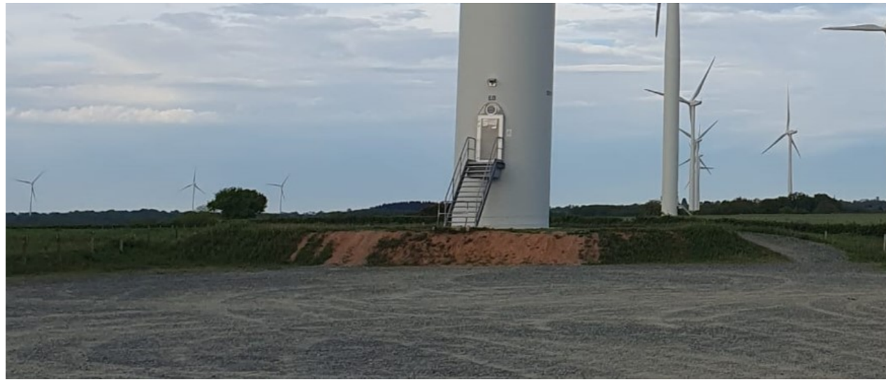
Photographie 7 - Massif béton stabilisé
