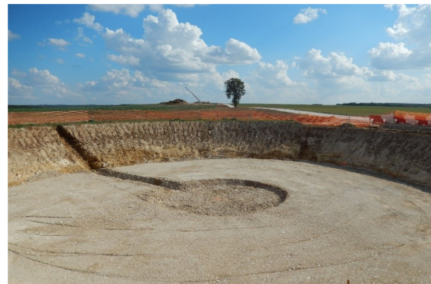
Photographie 5 - Excavation d'une fondation (préparation de l'assise et du passage des fourreaux)
