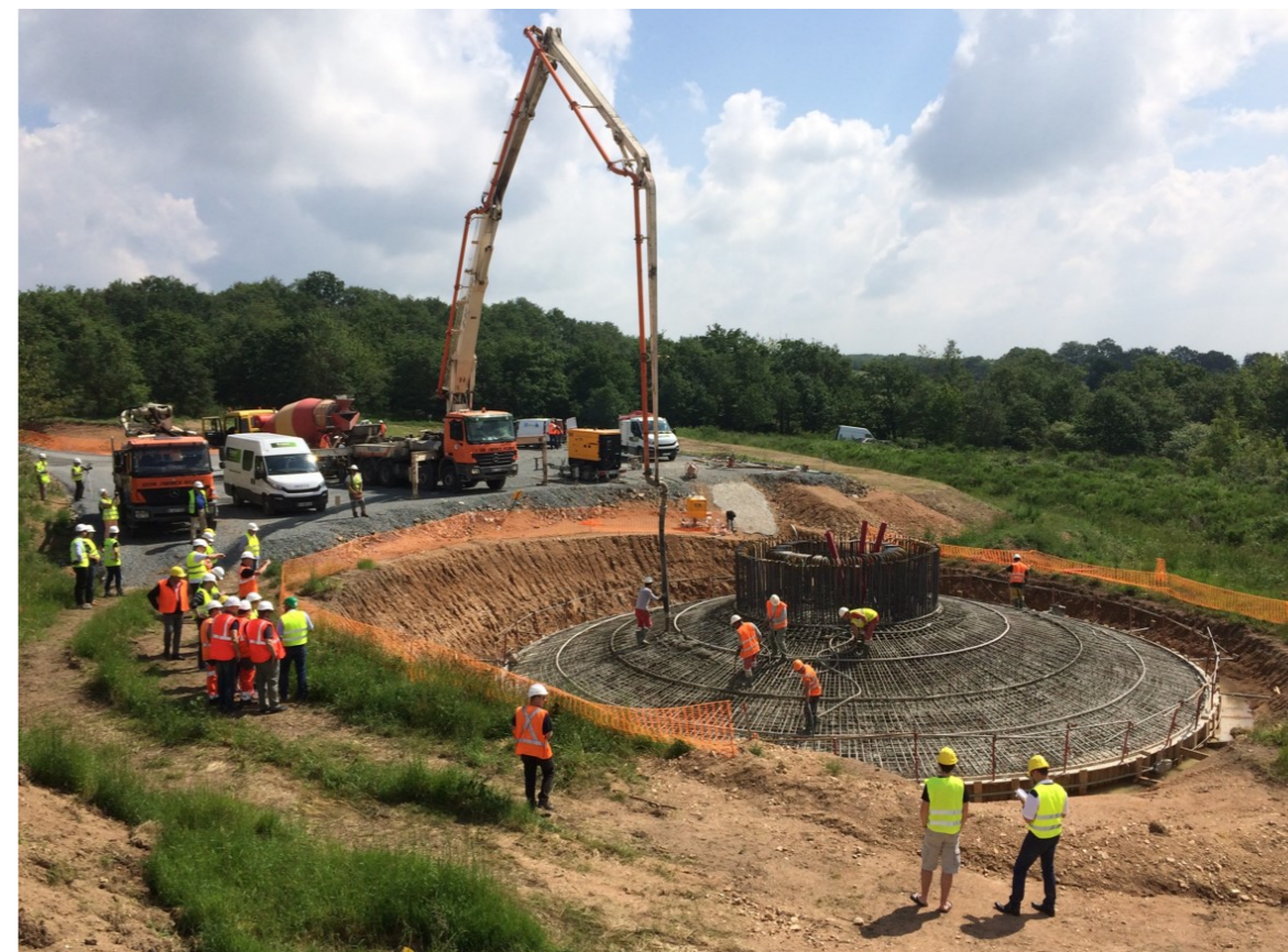
Photographie 6 – Mise en place de la fondation en béton armé
