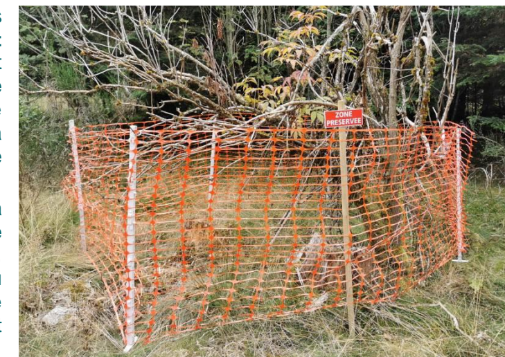
Photo 2: Exemple de balisage avant travaux
