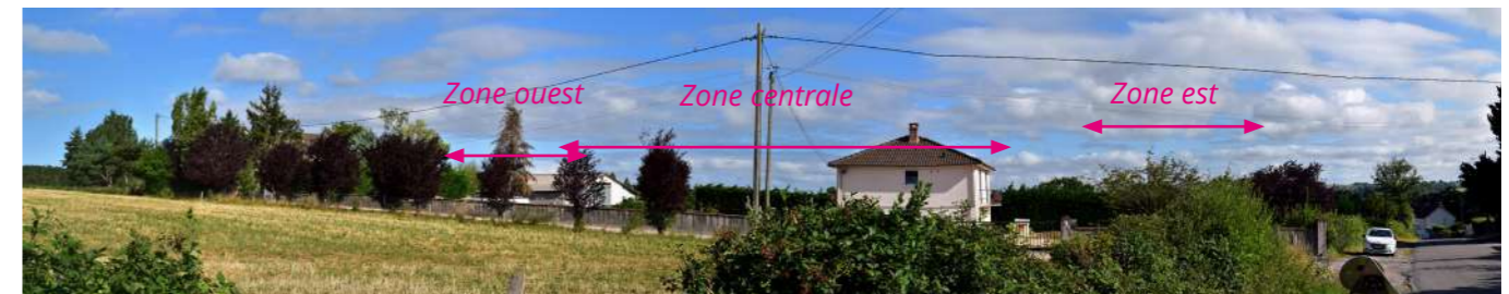
Photographie 70 : Vue partielle du site éolien depuis la D239 au sud de Chamblet.
