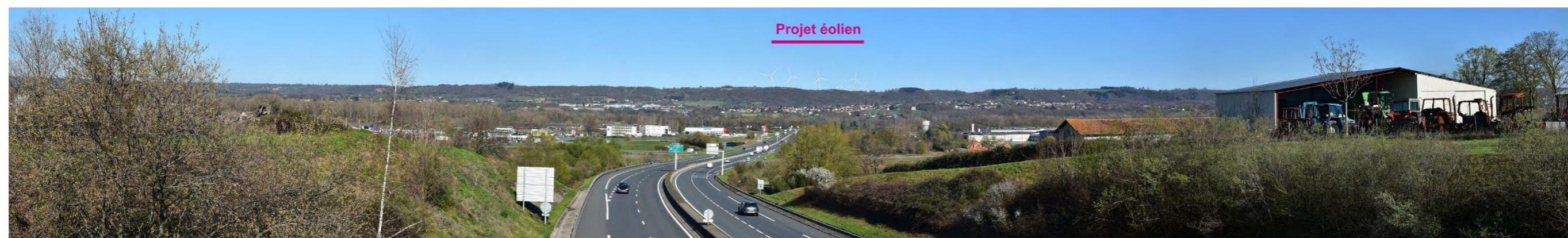
Photographie 14 : Visibilité partielle du projet dans l'axe de la N145 depuis le pont de la D601, sur le contournement de Montluçon
