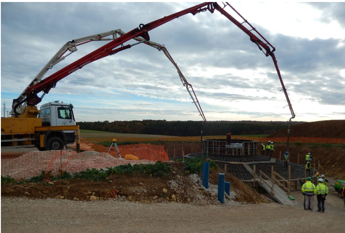
Fondation pendant le coulage du béton
