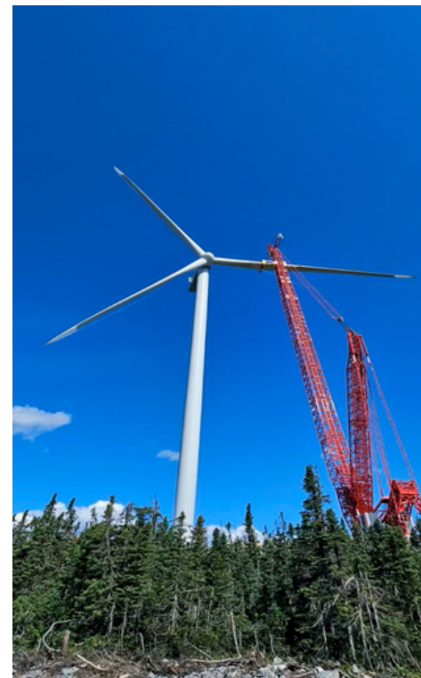
Montage d'éolienne parc Apuiat au Québec
