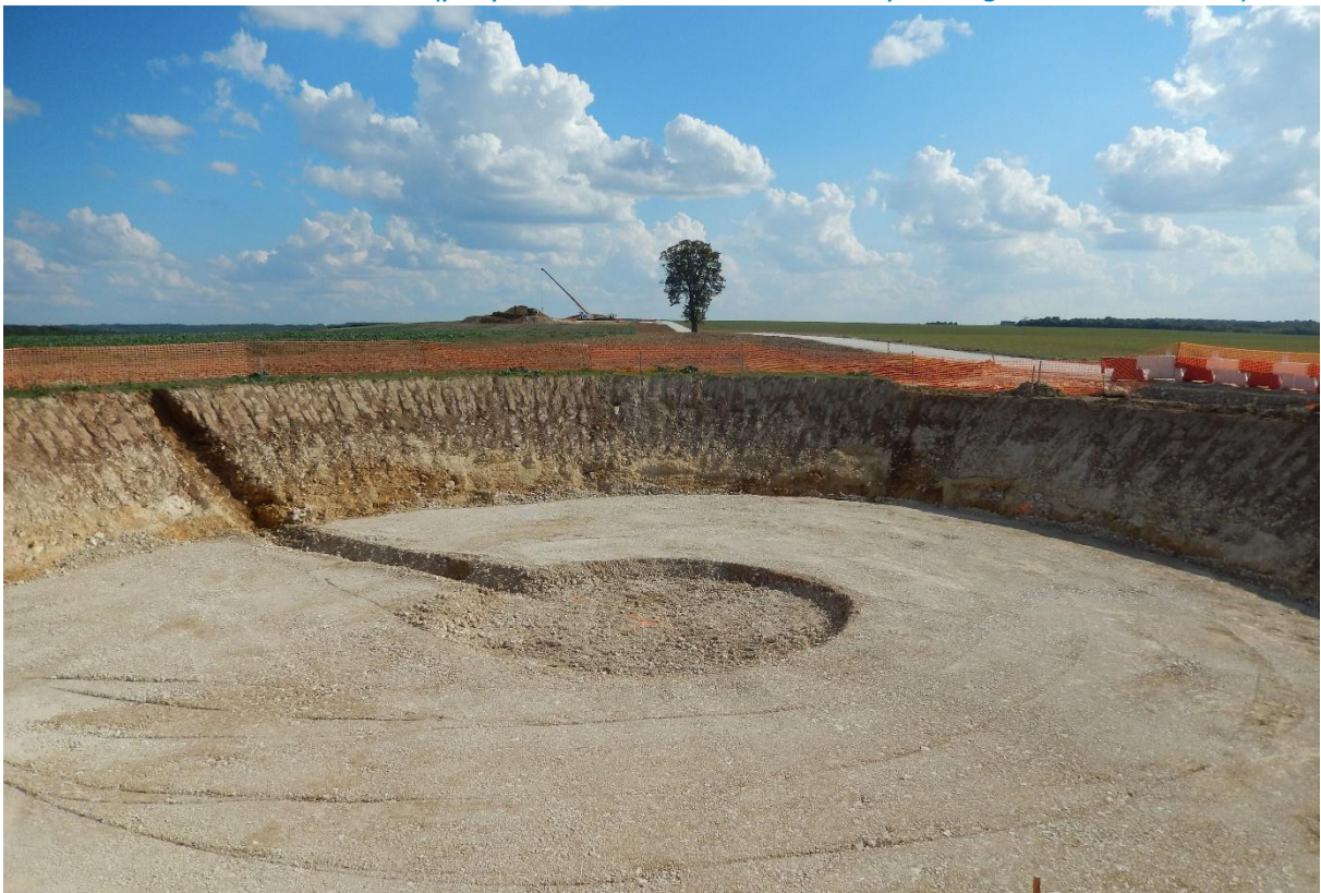
Excavation d'une fondation (préparation de l'assise et du passage des fourreaux)
