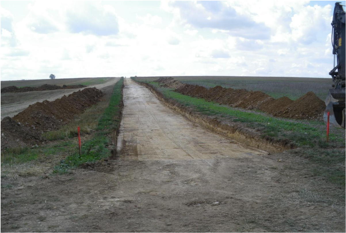
Excavation d'une fondation (préparation de l'assise et du passage des fourreaux)
