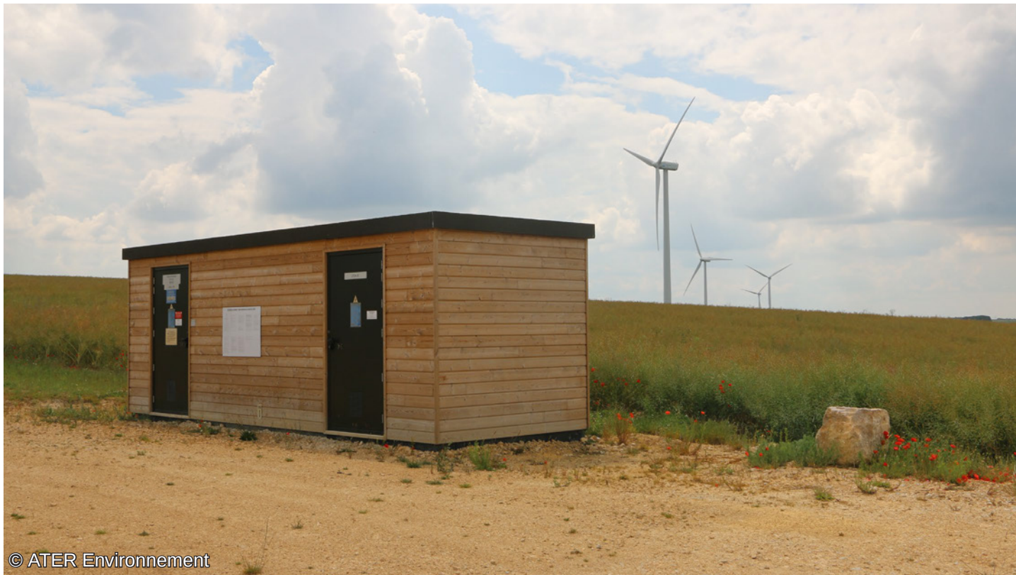
Fig. 152 : Exemple de poste de livraison en bois avec toit plat
