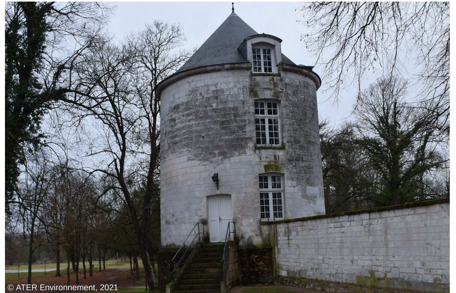
Fig. 63 : Tour du Château d'Arcis
