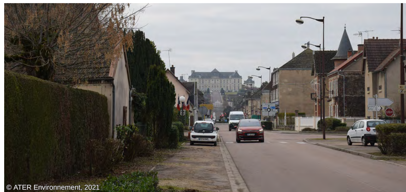
Fig. 101 : Vue sur le Château de Brienne surplombant la ville, depuis le centre-bourg
