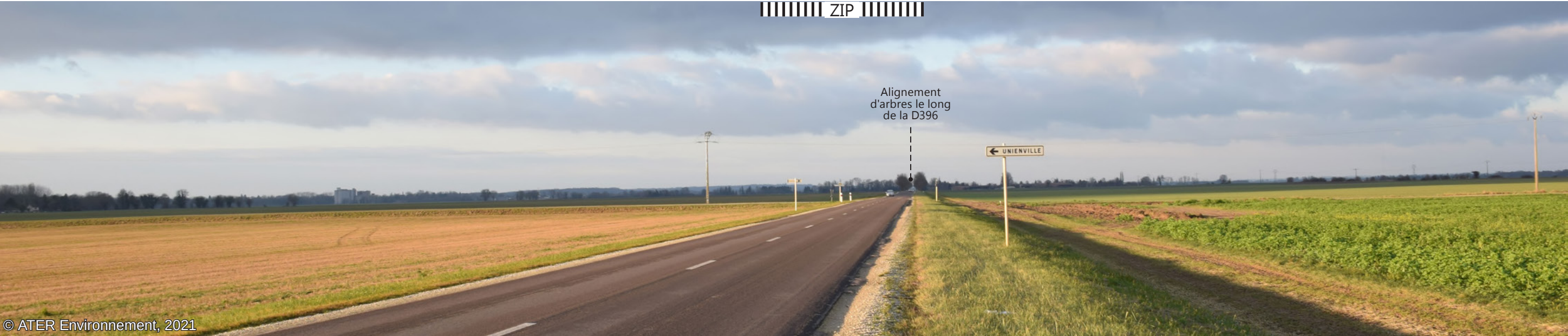
Fig. 33 : Vue depuis la 396 entre Tranne et la Rothière, au sud-est de l'aire d'étude
