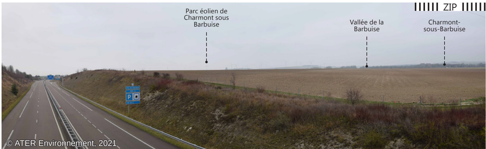
Fig. 30 : Vue sur l'A26 aux abords de Charmont-sous-Barbuise. La route est en décaissé par rapport au plateau agricole, ce qui limite les vues lointaines
