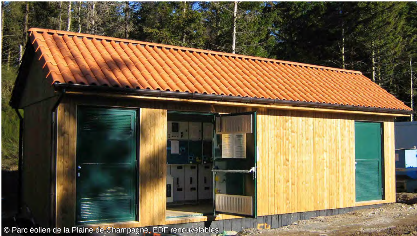
Fig. 156 : Exemple de poste de livraison en bois avec toiture en tuiles à deux pans
