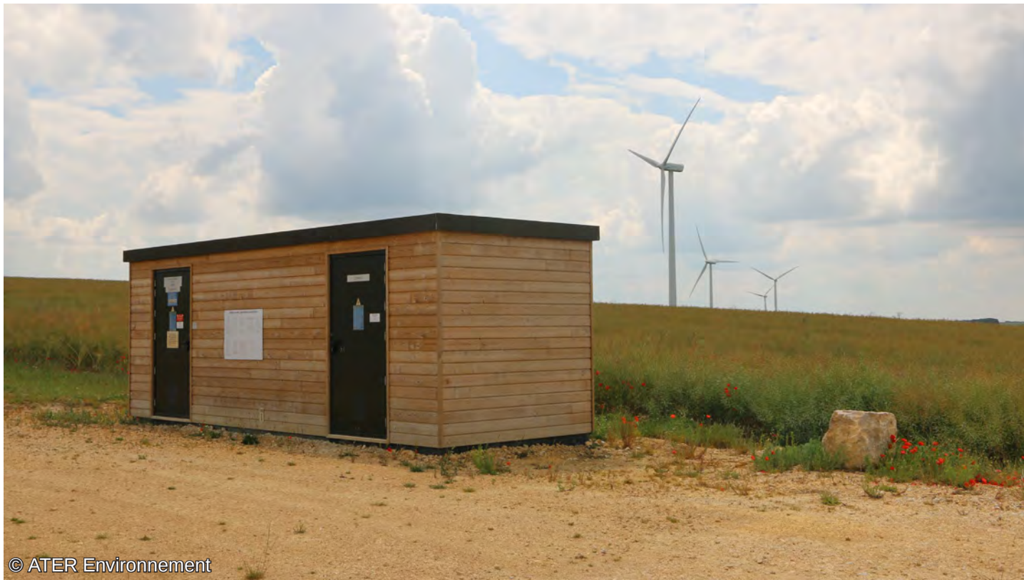
Fig. 155 : Exemple de poste de livraison en bois avec toit plat
