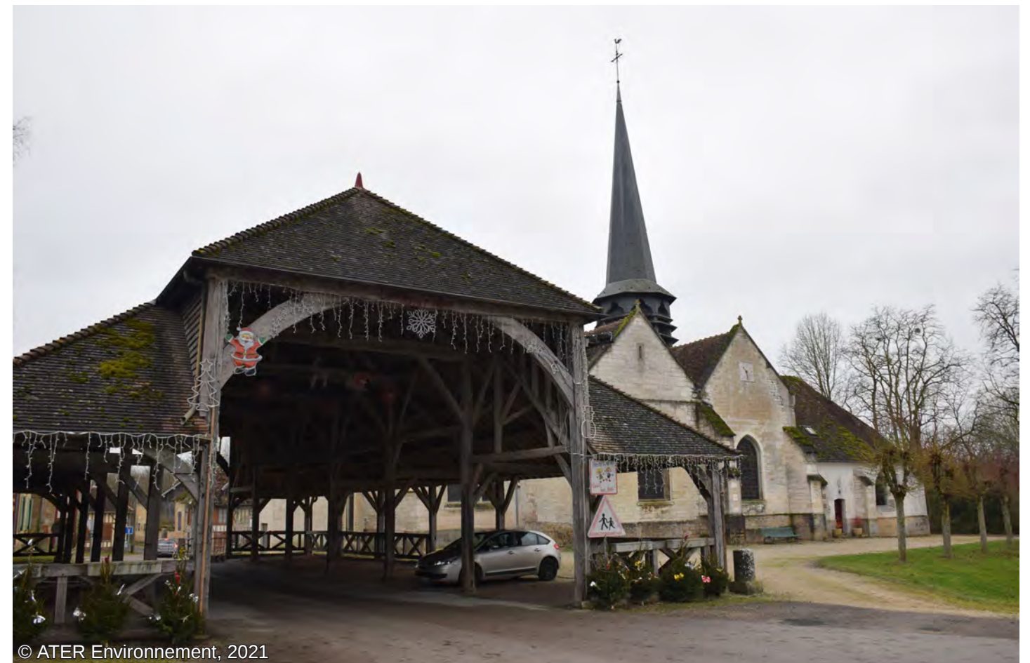
Fig. 139 : Église et Halle de Lesmont
