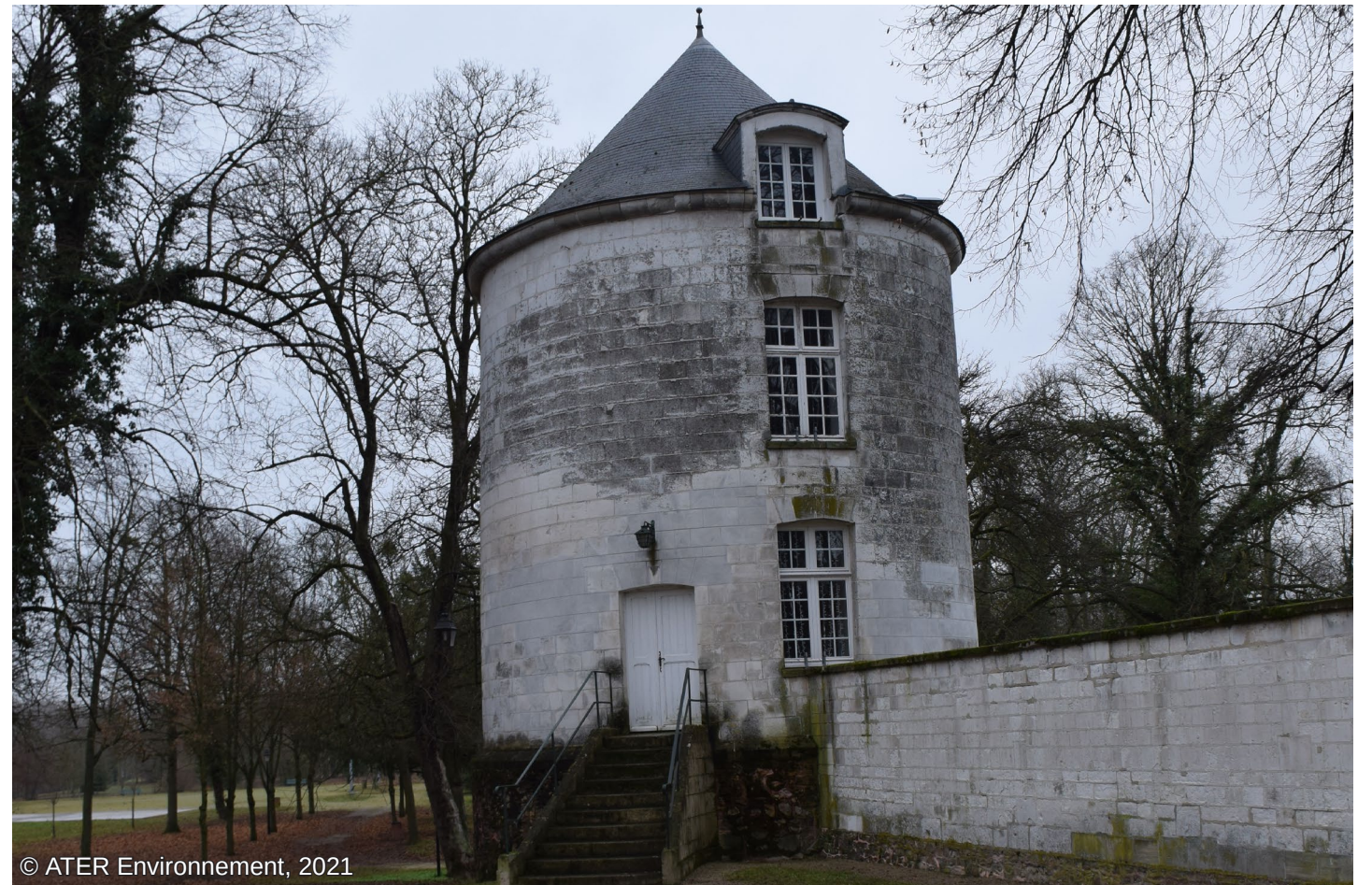
Fig. 68 : Tour du Château d'Arcis
