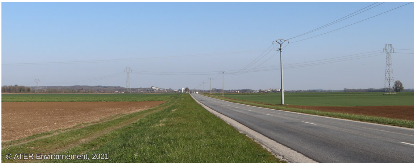
Fig. 24 : Vue dégagée depuis la D396, en direction de Brienne-le-Château.
