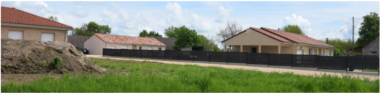
Les maisons en construction – Avril 2025
