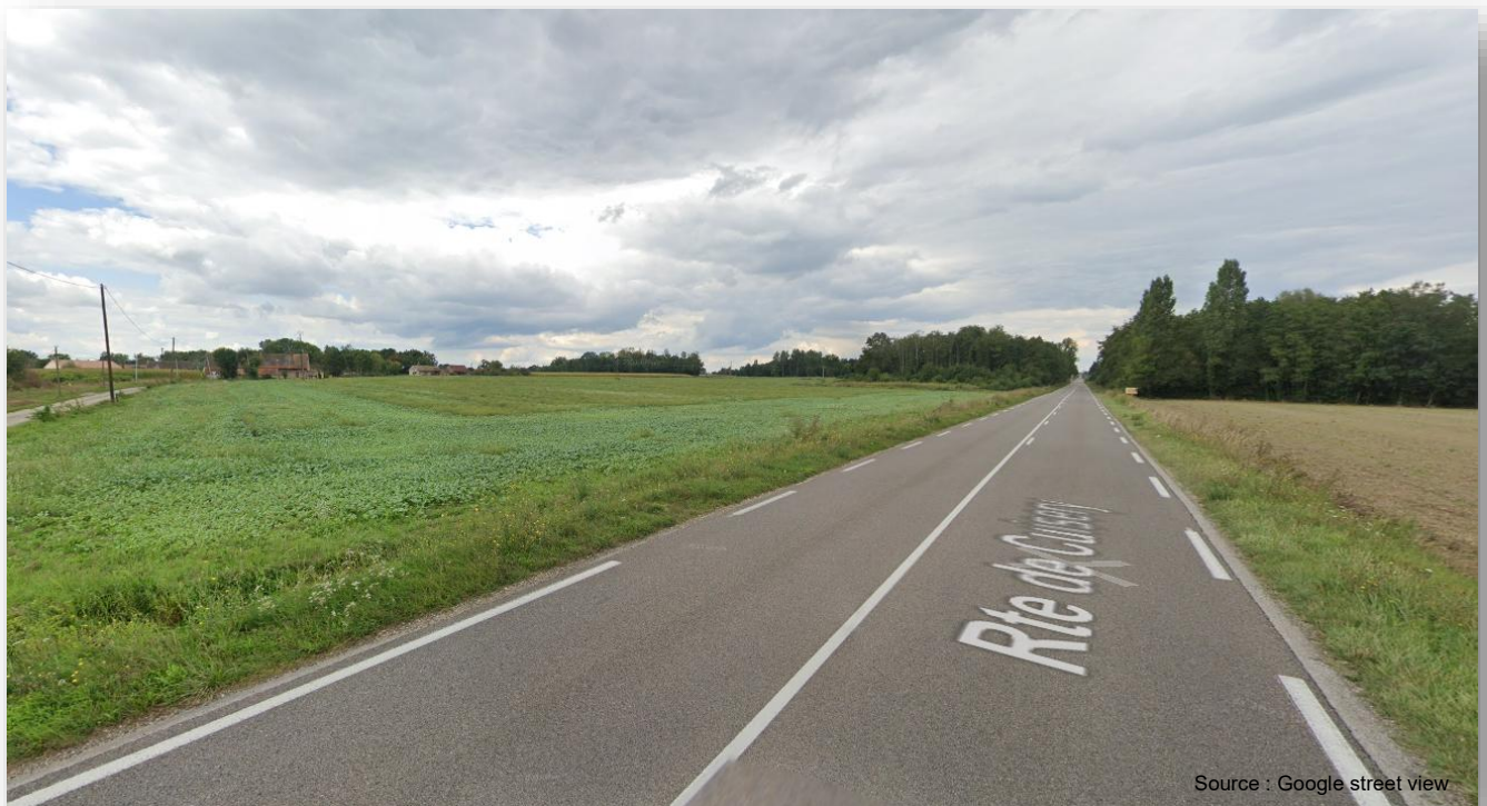
Vue vers le nord depuis la RD 933
