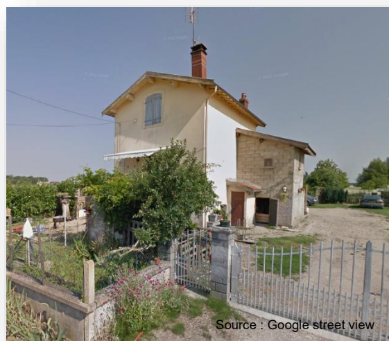
Ancienne maison de gare, route de la ligne
