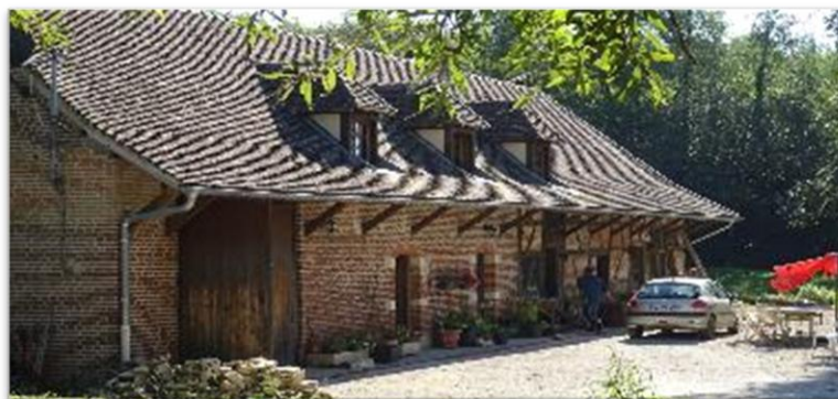
Figure 40 : Exemple d'ouverture en toiture d'une ancienne ferme bressane à Lessard en Bresse, Mosaïque Environnement
