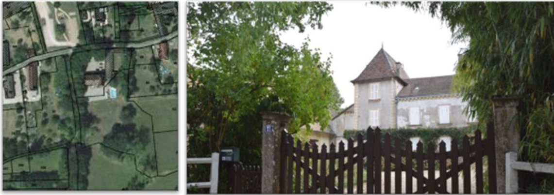
Figure 64 et 65 : Photographie et vue aérienne d'une maison bourgeoise à Loisy, Mosaique Environnement
