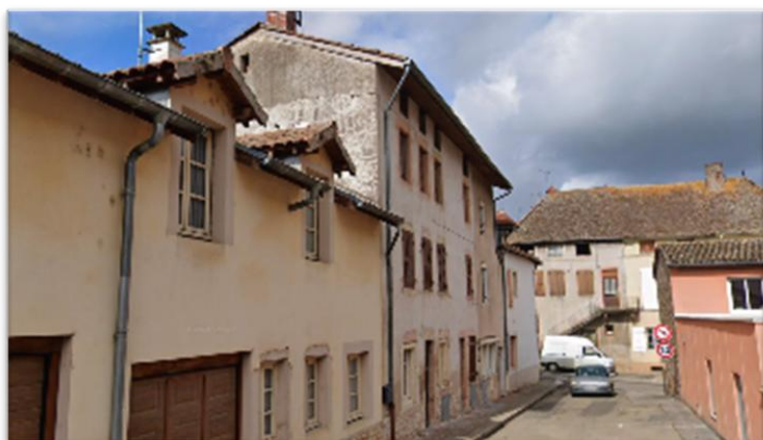
Exemple d'enduits de façade à Cuisery, Mosaique Environnement
