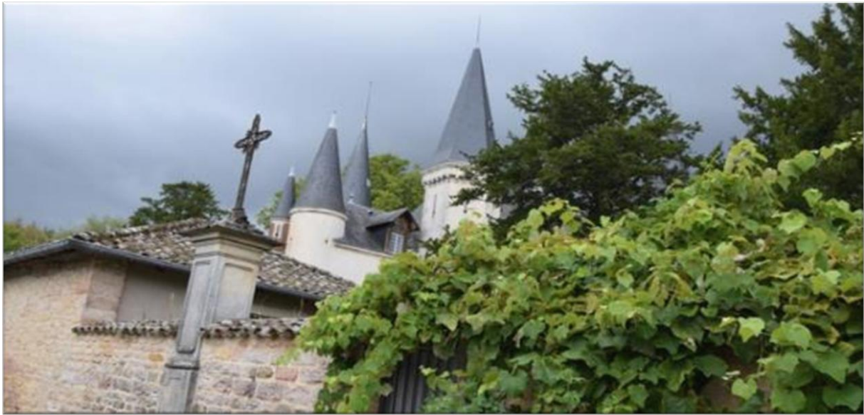
Château de Montrevault à Cuisery, Mosaïque Environnement
