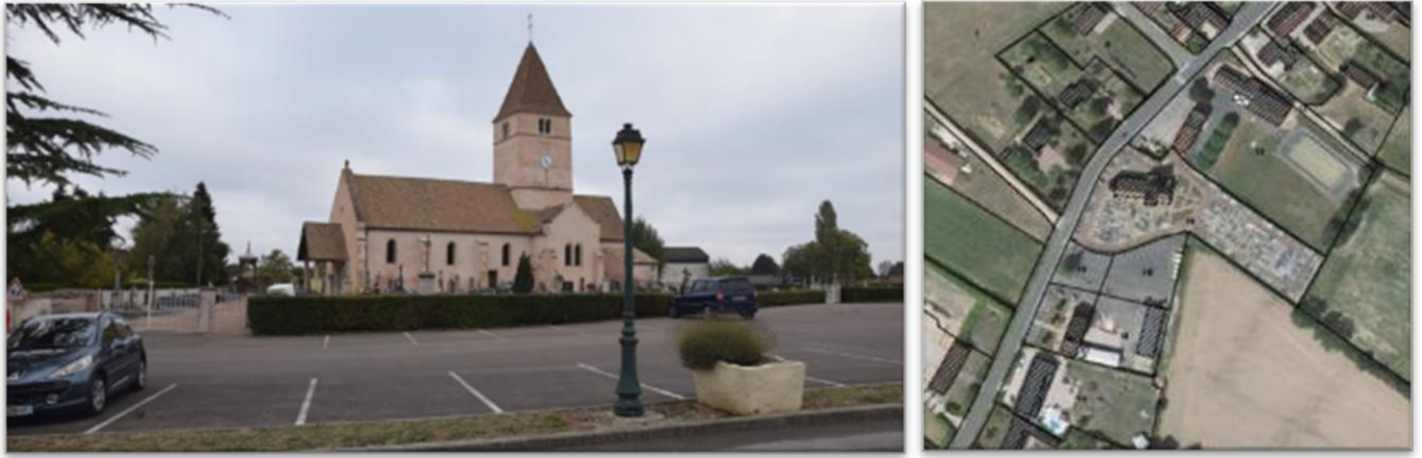
Figure 56 et 57 : Photographie et vue aérienne de l'église de La Genête, Mosaïque Environnement
