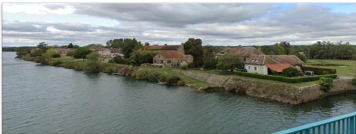
Figure 45 : Port de Ouroux sur Saône, Mosaïque Environnement
