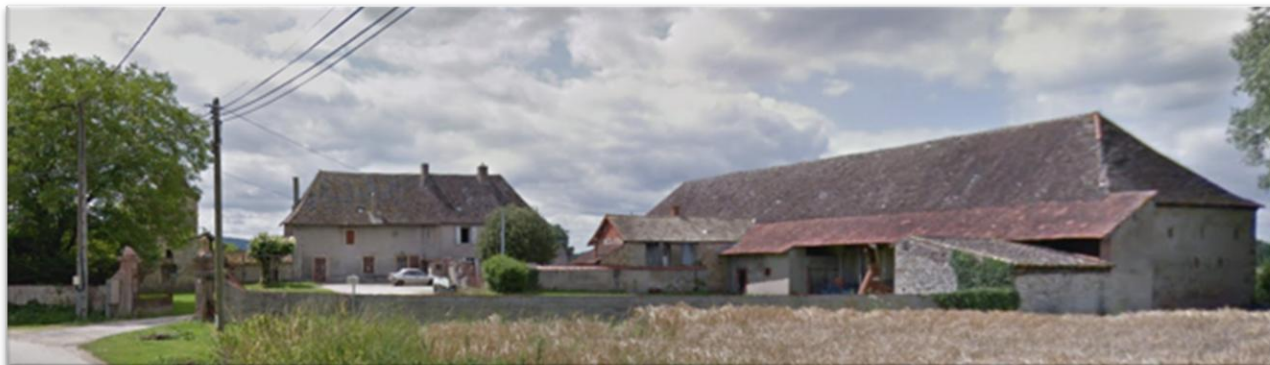
Figure 73, 74 et 75 : Photographie et vue aérienne de l'ensemble d'un corps de ferme à Simandre, Mosaïque Environnement
