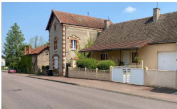
Le paysage urbain révèle un contraste entre les maisons bressanes et les constructions au style industriel
