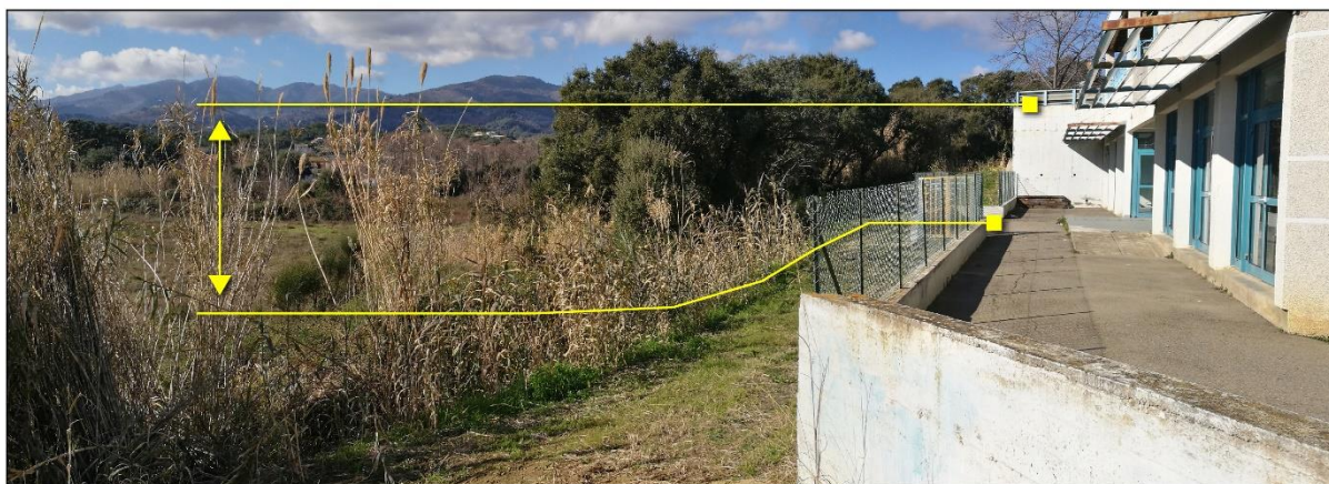
2 - à nouveau une vue de la rupture de pente sous le bâtiment de l'école, au sud de Casanile. La vue est vers le nord.
