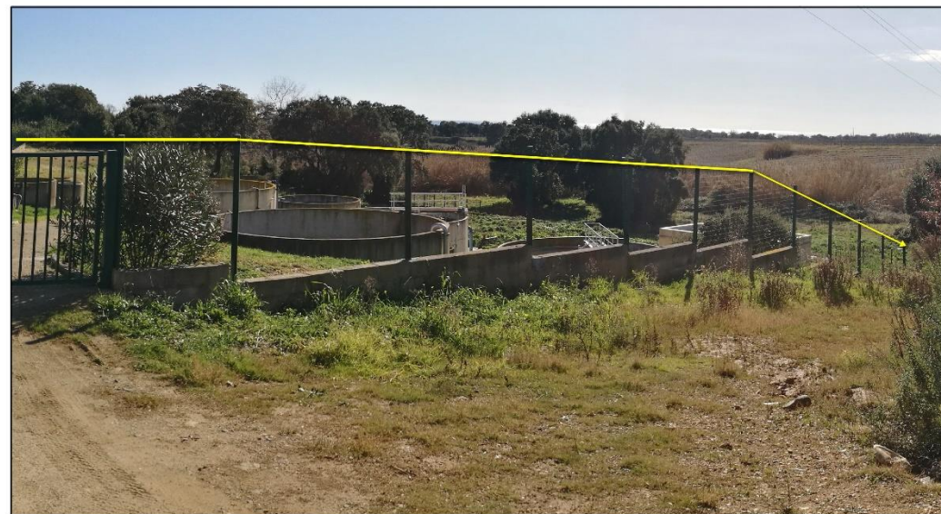
5 - la station d'épuration, en bout de plateau. La clôture est un excellent indicateur de la pente qui s'accroît en allant vers la plaine.
