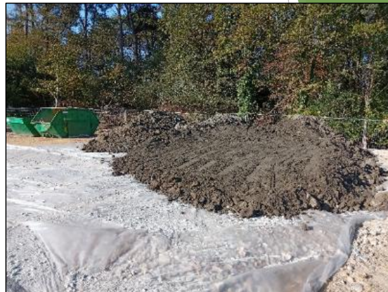
Stockage des terres impactées sur bâches avant évacuation
