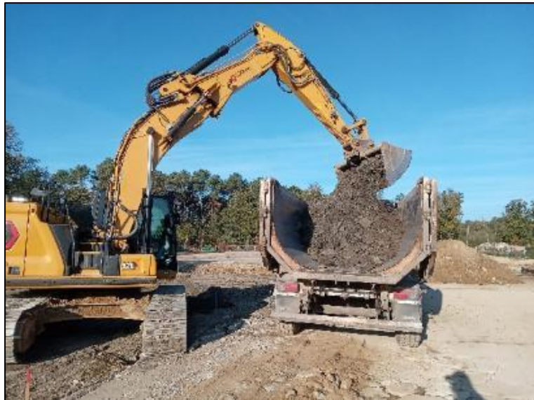
Terrassement de la zone impactée
