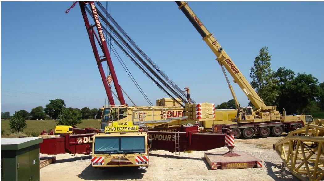
Photo 3. Montage d'une grue de levage
