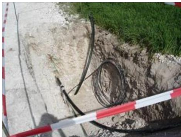
Figure 12 : Tranchée pour le passage des câbles électriques
