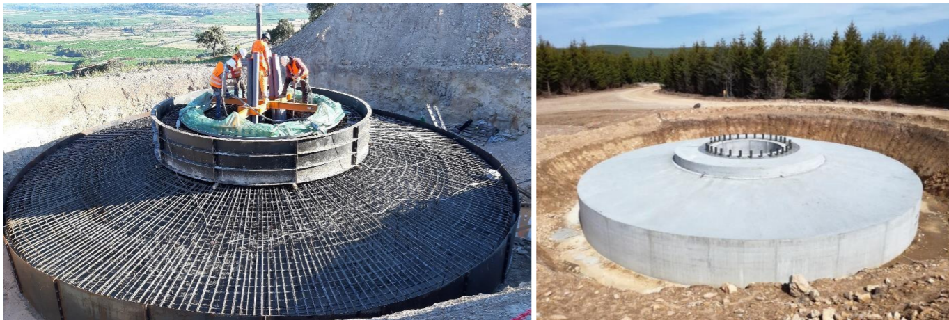
Figure 32 : Fondations d'une éolienne (source : Synergis Environnement)
