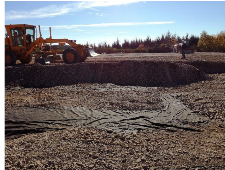
Figure 33 : Illustration de la mise en place d'une plateforme (source : Synergis Environnement)
