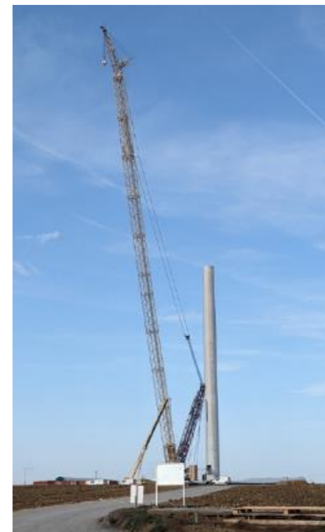
Figure 23 : Grue principale sur la plateforme (source : Gaïa Energy Systems)
