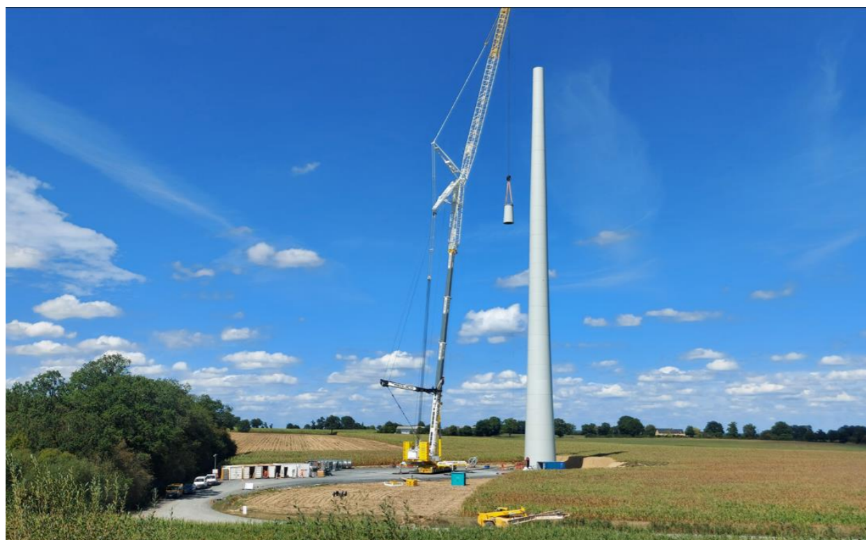
Photo 2 : Installation d'une éolienne (Source : AEPE-Gingko)
