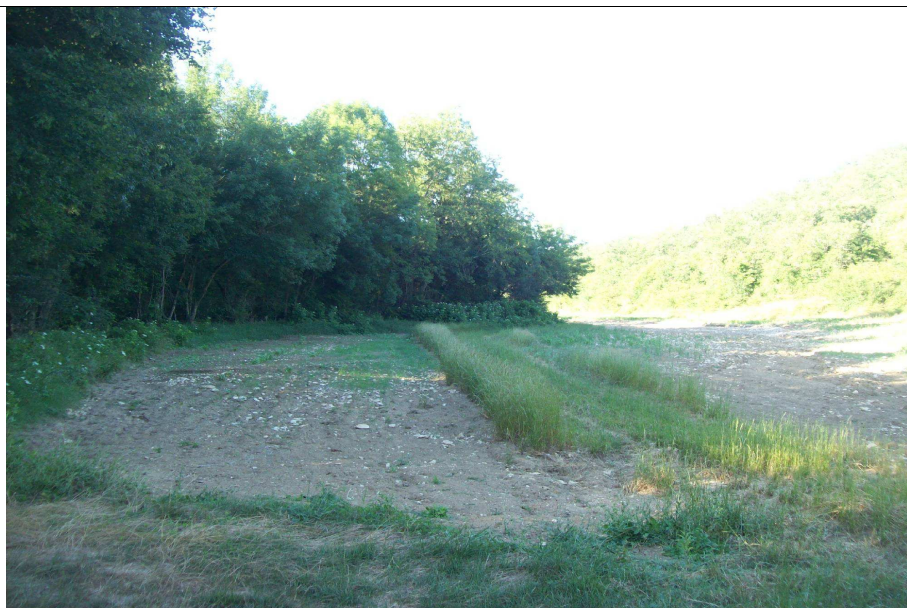
Aval du chemin franchissant le ruisseau, rive droite avec dépôts importants
