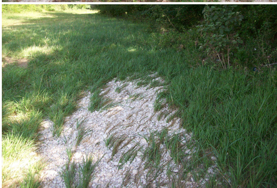
Laisse de crue en amont du viaduc SNCF (déboché de l'ouvrage sous route) => vitesses fortes
