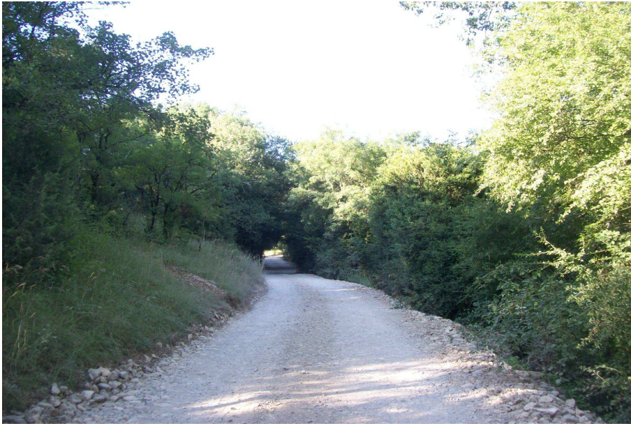
Chemin en remblai et friche à droite
