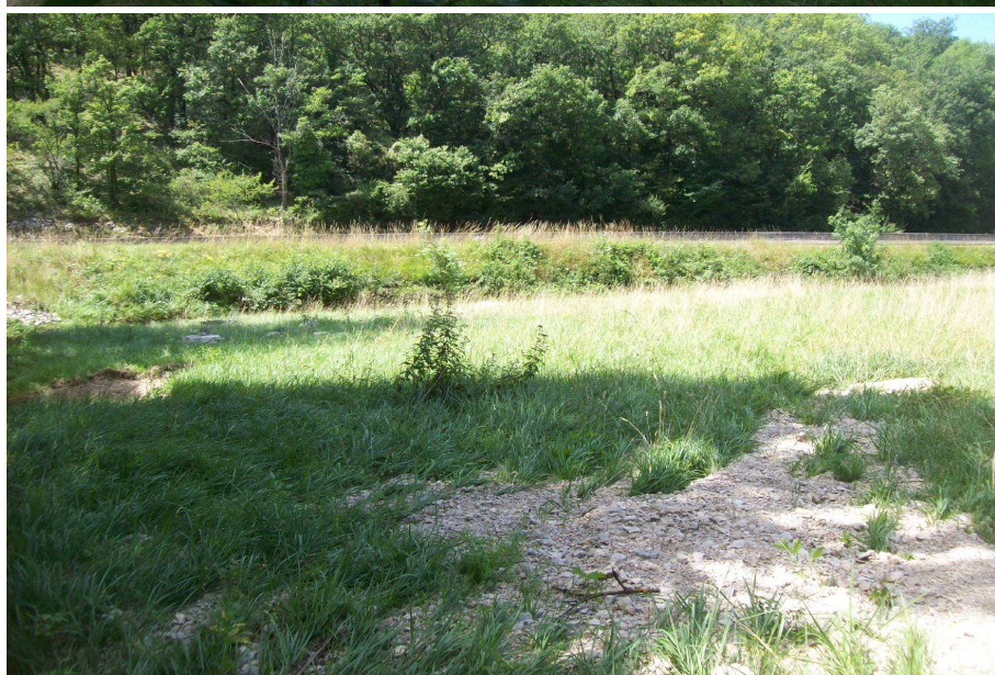
Dépôt de gravats en RG en aval du ponceau (laisse de la crue du 11/06/2010 témoignant de fortes vitesses)
