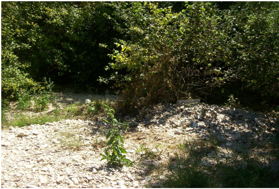
Lit mineur comblé à la traversée de la zone d'expansion
