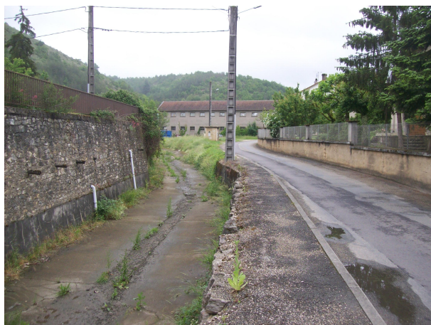
PCH01 – amont Cahors Médical : la vallée présente un rétrécissement ponctuel accentué par le bâti (largeur inférieure à 30 m), point de passage obligatoire de tout le débit
