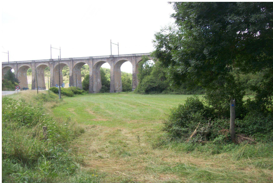
Entre viaduc SNCF et la route de Raux Haut (submergée partiellement le 11/06/2010) (vue dans le sens aval -> amont)
