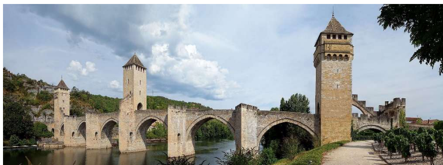
Pont Valentré – Source Wikipédia
