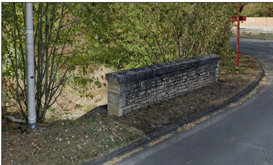
Figure 121 : Zone de raccordement aval du tronçon Agasse 2 - Parapet de l'ouvrage de franchissement routier
