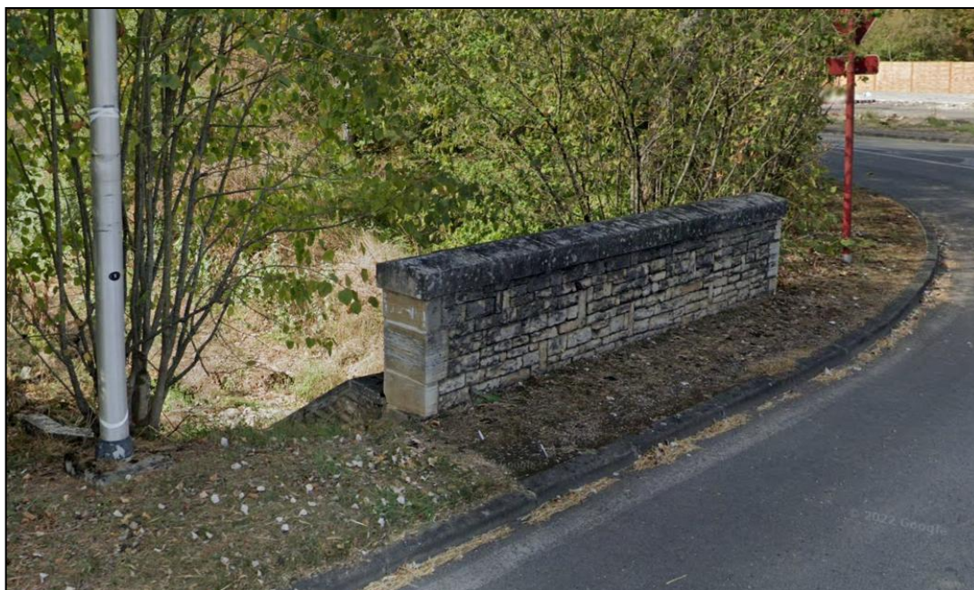
Figure 123 : Zone de raccordement amont du tronçon T2- Parapet de l'ouvrage de franchissement routier
