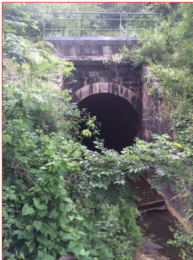
Entrée Est du tunnel
