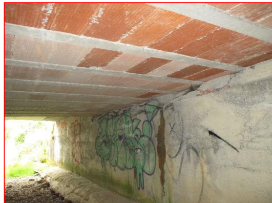
mur de droite en béton.
