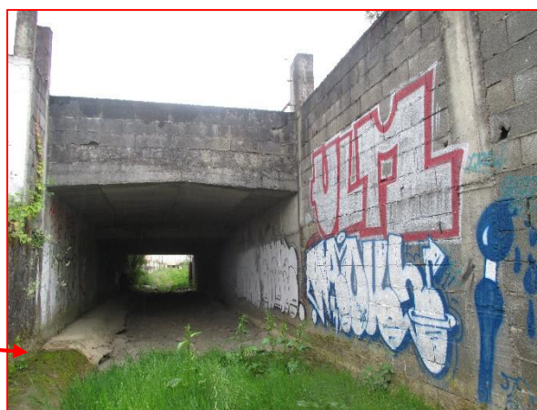
Dalle en béton, sans désordre apparent.
