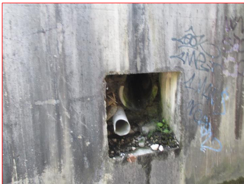
Evacuation dans le mur retour à la sortie de l'ouvrage.
