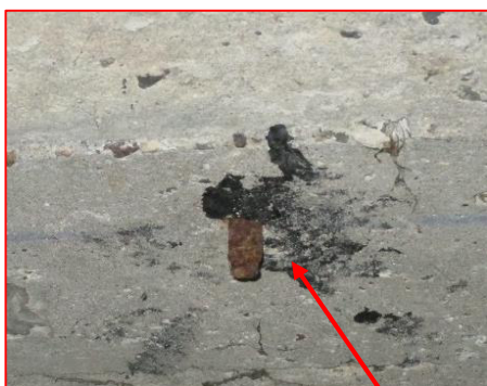
On observe 2 tiges scellées dans la dalle distancées d'environ 1.65 m.
