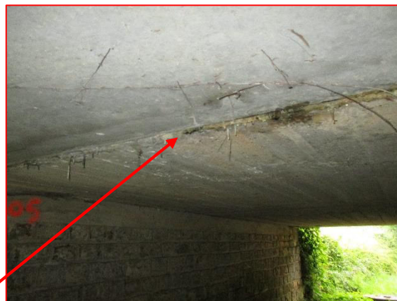
Joint humide entre les deux structures de dalle.
