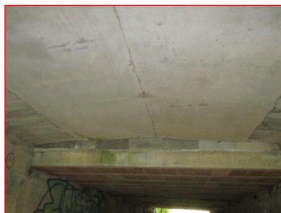
Dalle en béton, sans désordre apparent.
