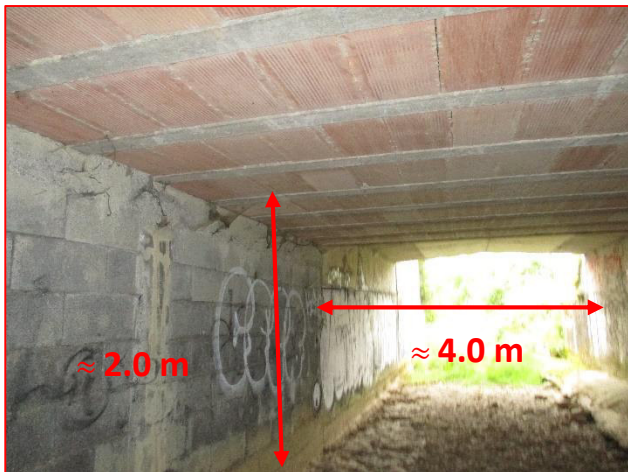
Dalle en poutrelles hourdis en terre cuite
