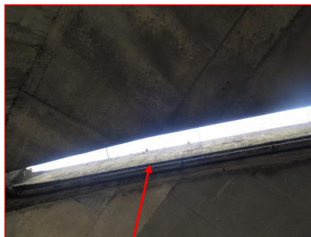
Des fourreaux passent au niveau du joint de la dalle.
