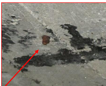
On observe 2 tiges scellées dans la dalle distancées d'environ 1.65 m.
