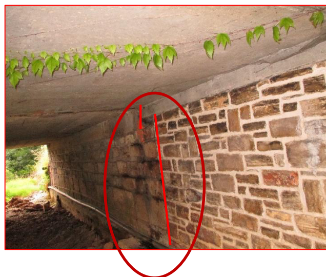
La dalle en béton armé coffrée s'appuie sur des poutres béton de 25 cm de retombée.
