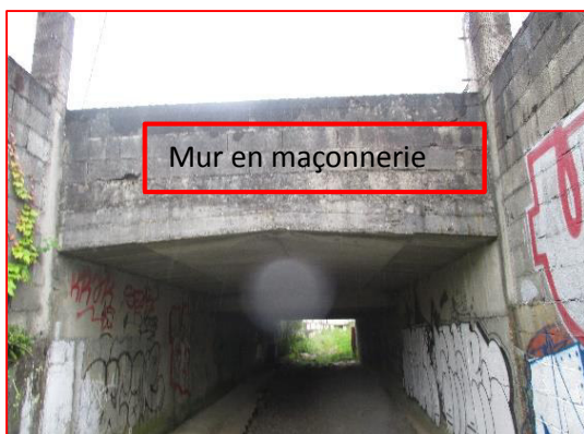
Dalle en béton, en forme de V inversé.
