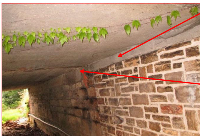
Dalle en béton armé coffré sur 7.60 m.
