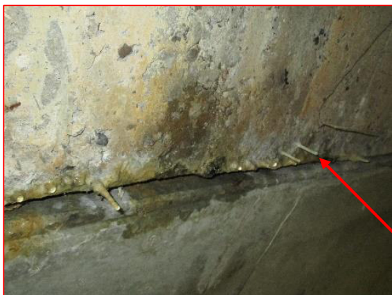
Joint humide entre les deux structures de dalle.
