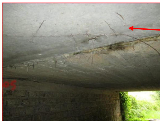
Dalle en béton armé coffré sur 7.60 m.
