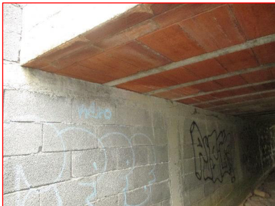
Mur de gauche en parpaing
