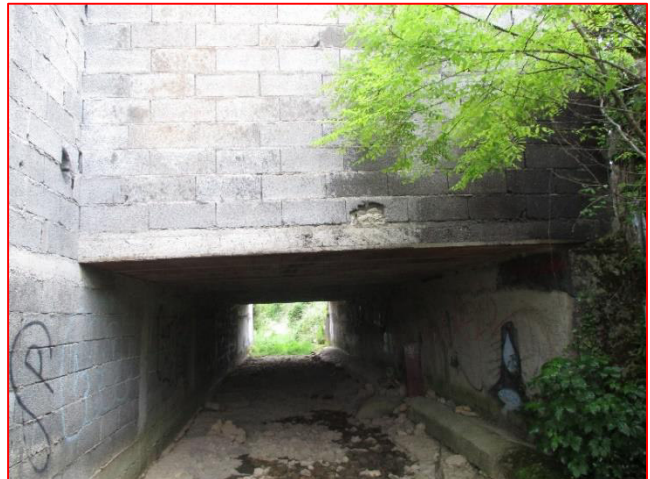
Vue amont de l'ouvrage
