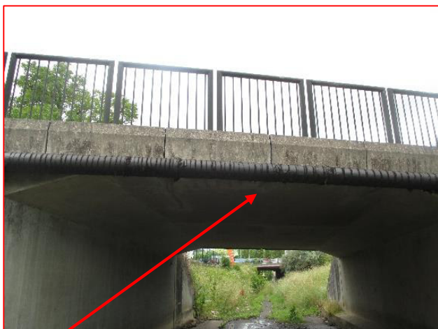
Canalisation qui traverse transversalement le long de la dalle. Vue amont
