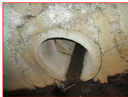
Présence d'un regard.
