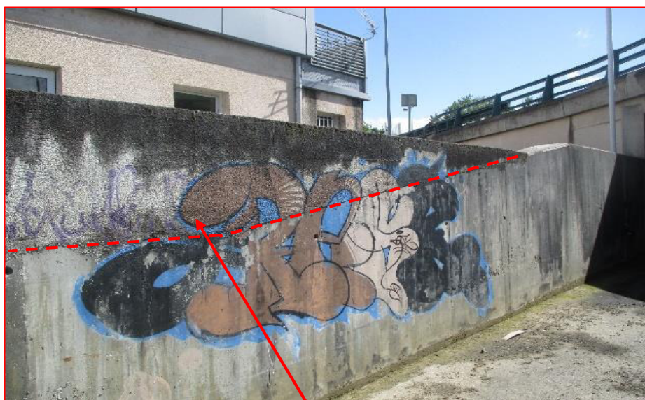
Mur rehaussé, probablement pour servir de garde-corps pour le passage arrière qui est plus haut.
