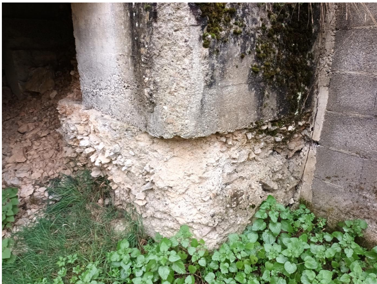
Figure 23 : Terrassement sub-vertical au niveau de la fondation de la sortie Nord
