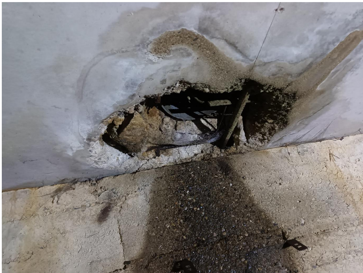
Figure 18 : perçage de la voute pour mise en place d'une canalisation d'eau
