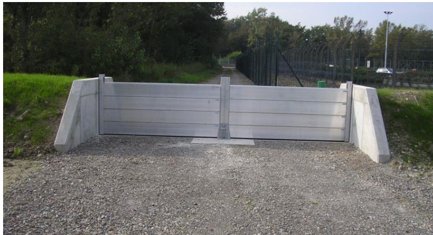
Exemple d'un dispositif de batardeau à poutrelles
