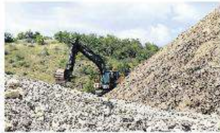
Les travaux de déviation du ruisseau du hantessac, à Cahors, sont en cours.
