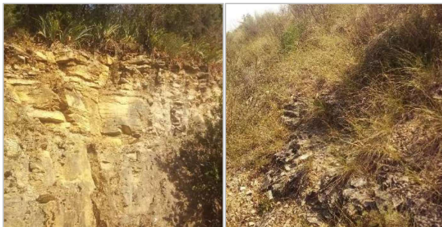
Photos 25 : Photos témoignant des affleurements rocheux calcaires et de l'insondabilité locale du sol au sein de l'UTS 2 – Photos prises sur site, © Rainette, 2024
