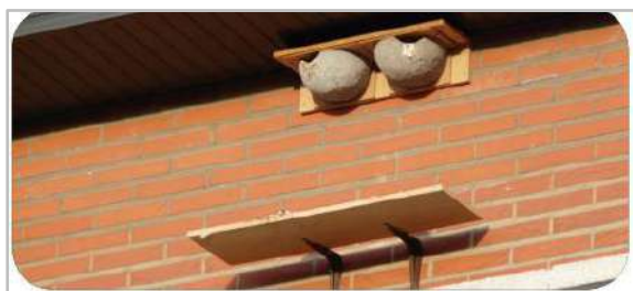
Photo 101 : A gauche nids artificiels d'Hirondelle avec planchette, © Charlie Carels – GTH ; A droite, schéma d'installation de planchette à déjections, © Natagora
