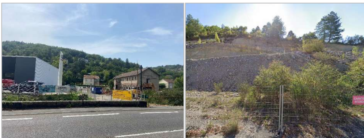
Photos 23 : Zone urbanisée (à gauche), et chantier (à droite), © Rainette 2024
