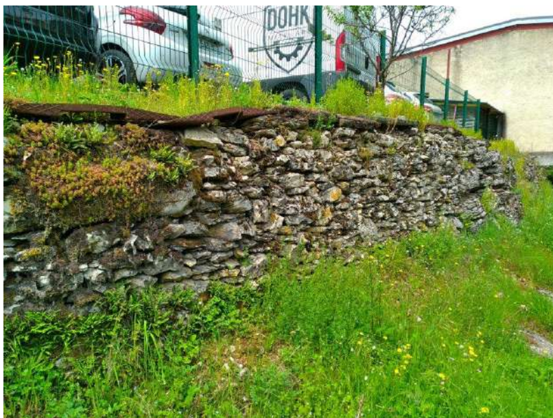
Figure 33 : Muret délimitant le cours d'eau favorable aux reptiles communs © ETEN environnement
