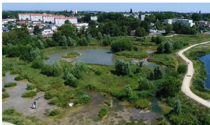
Zone d'expansion de crue, Gonesse - SIAH
