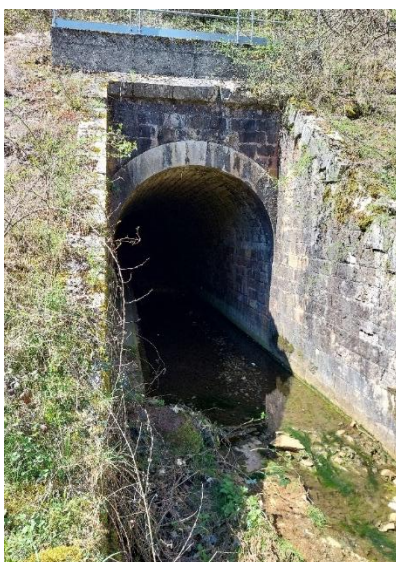
Vue du Bartassec depuis la sortie aval de la voute de la voie ferrée
