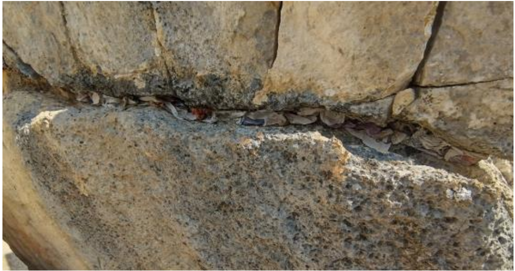
Exemple de fissure bouchée à l'aide de journal
