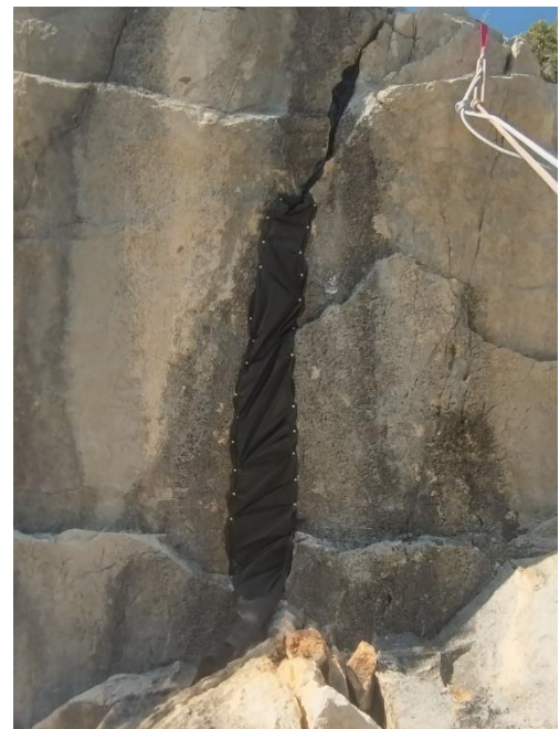
Exemple de comblement de fissure à l'aide de géotextile et de chevilles (cavité d'origine à gauche et bouchée à droite)
