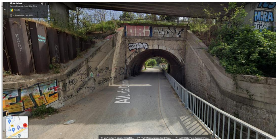
Figure 27 : Vue de l'ouvrage de franchissement de la SNCF
