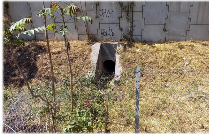
Figure 21 : Exutoire de la buse DN1000 traversant l'A8
