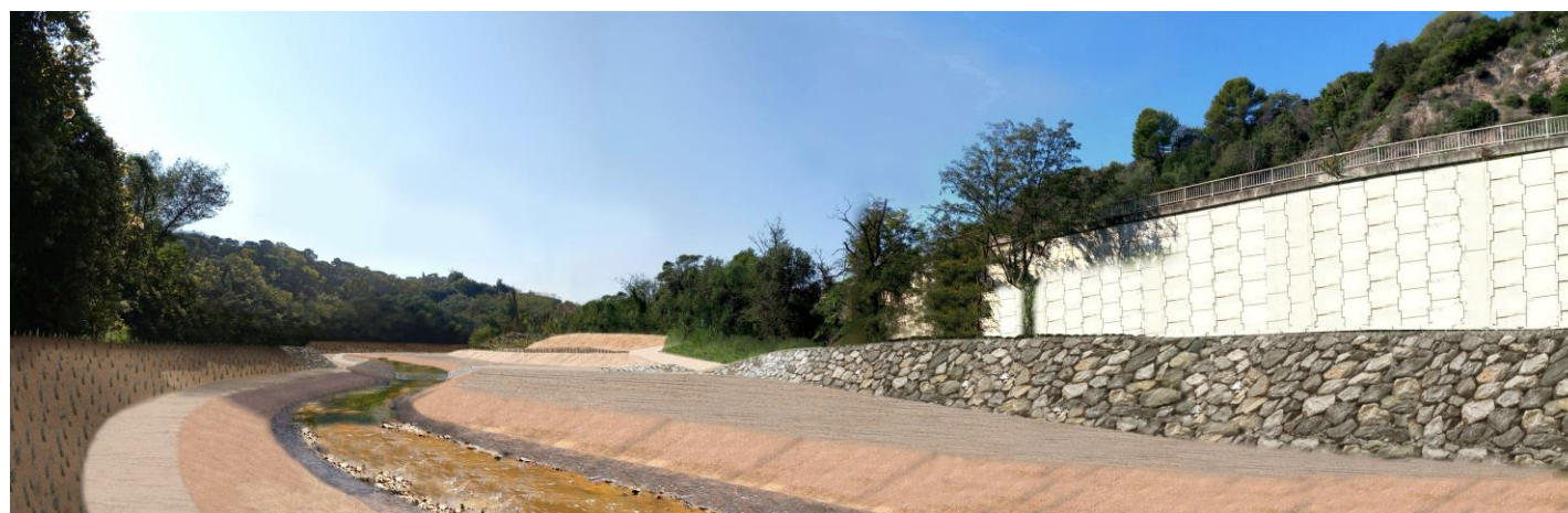
Après travaux à la plantation
