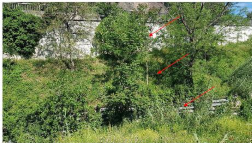
Mur en remblais renforcé, talus et mur en acier galvanisé
