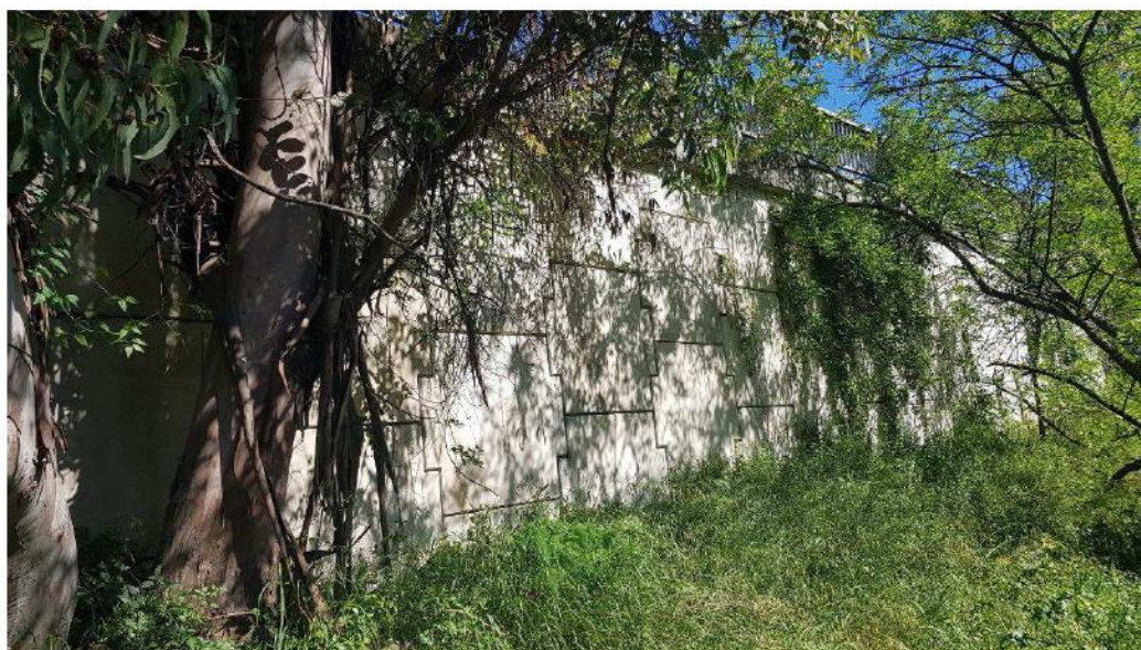
Mur en remblais renforcés (zone Sud) – hauteur 3 à 4 m (estimation visuelle)
