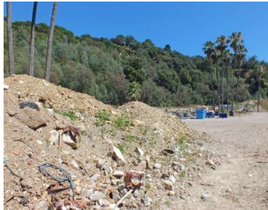
Tas de gravats dans la zone en travaux
