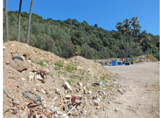
Tas de gravats dans la zone en travaux
