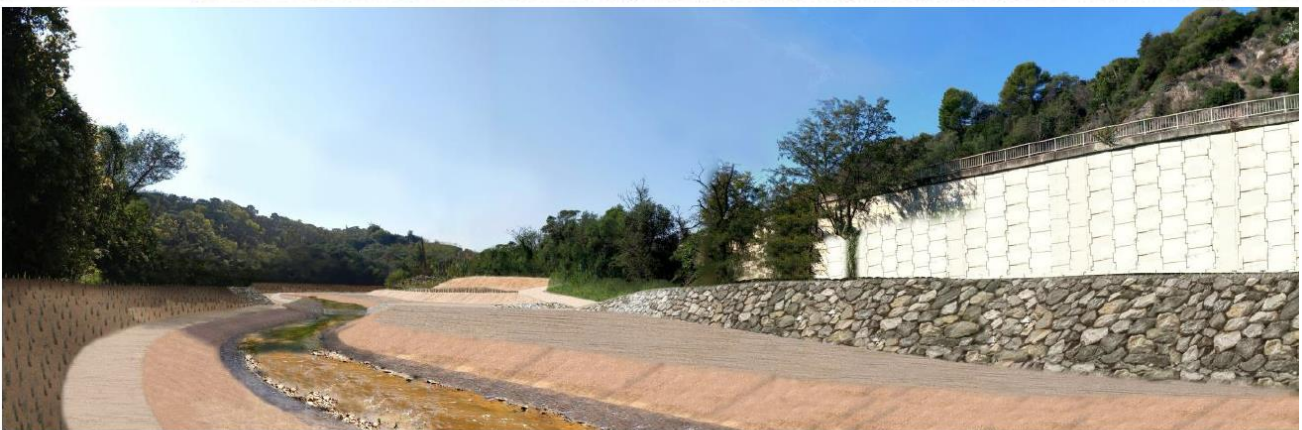
Après travaux à la plantation
