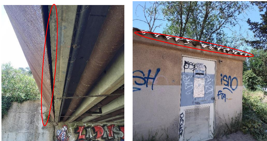
Pont (à gauche) et petit bâti (à droite), gîtes favorables pour les chiroptères fissuricoles (ouvertures cercles rouges)
