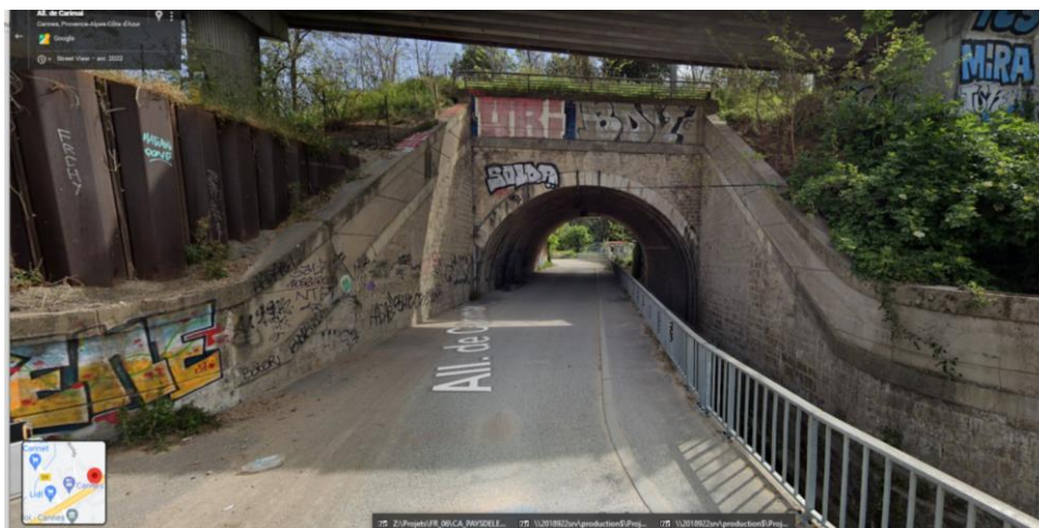
Figure 36 : Vue de l'ouvrage de franchissement de la SNCF
