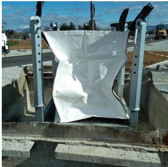
Figure 101 : Exemple de bassin de décantation mobile (Source : SUEZ Consulting)
