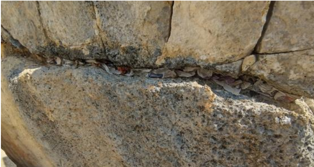
Figure 108 : Exemple de fissure bouchée à l'aide de journal
