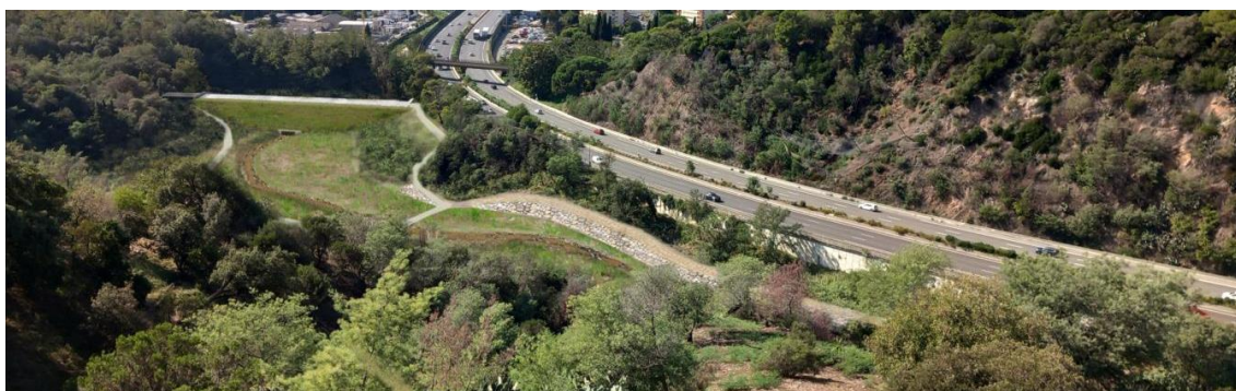
Figure 106 : Espaces verts de l'ouvrage à 10 ans (Source : Le Fur paysage)
