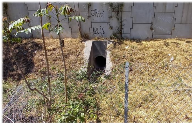
Figure 30 : Exutoire de la buse DN1000 traversant l'A8
