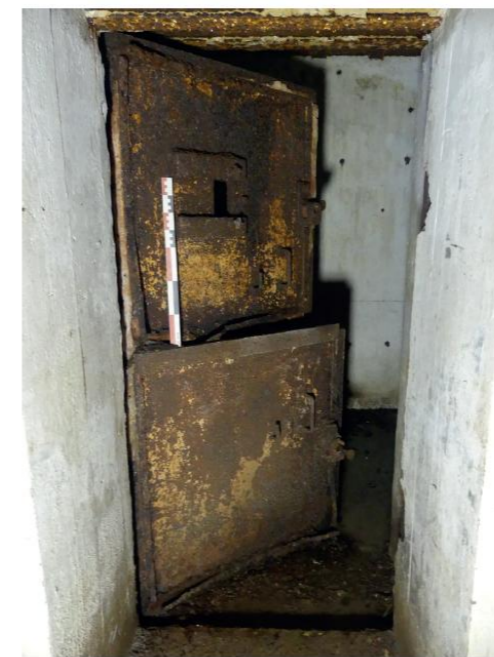
Fig. 104 : vue générale d'une porte à deux battants en place dans le bunker 319 © B. Labbey, Inrap
