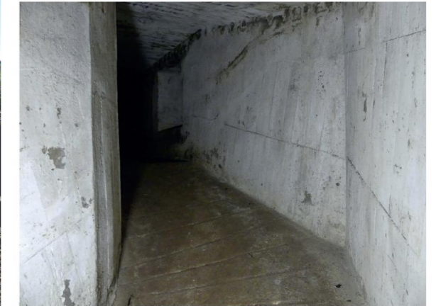
Fig. 116 : pente douce aménagée dans la partie coude de la galerie partant du bunker 301 © B. Labbey, Inrap
