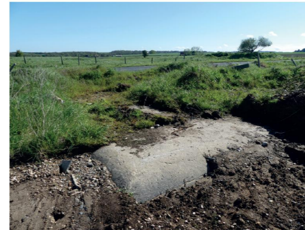
Fig. 123 : vue générale de la soute R607 © B. Labbey, Inrap
