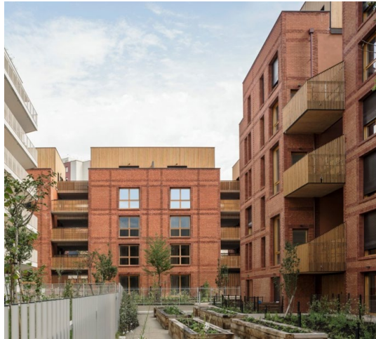
76 logements sociaux, Bagneux, I3F, Tolila Gilliland
