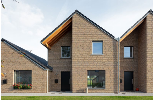
Logements social, Oost-Vleteren (Belgique) Urban Architectencollectief
