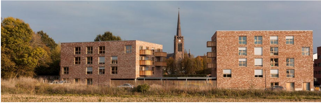
32 logements à Quesnoy-sur-Deûle, Logis Métropole, Atelier Hart Berteloot
