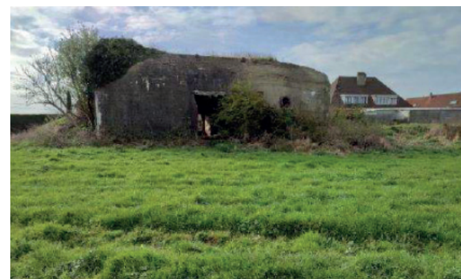
Vue n°1 : Bunker R680 situé à l'entrée Nord Est du site
