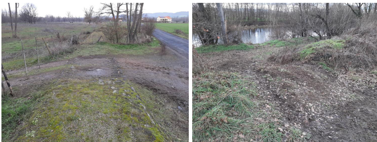
Figure 14 : Points bas au niveau de rampes d'accès (Observations 30 et 47)
