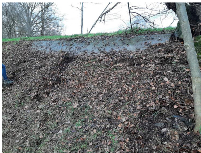
Figure 12 : Gabions recouverts de terre/feuilles
