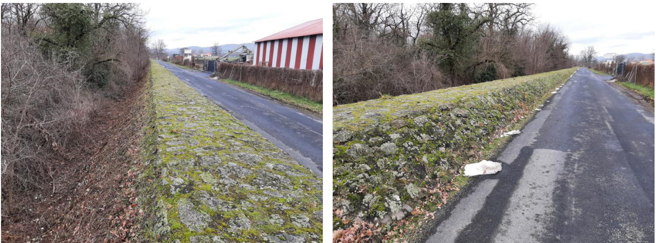
Figure 3 : Vues du tronçon n°2 – partie 1
