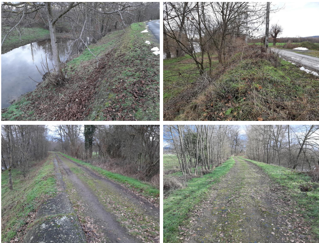
Figure 5 : Vues du tronçon n°3
