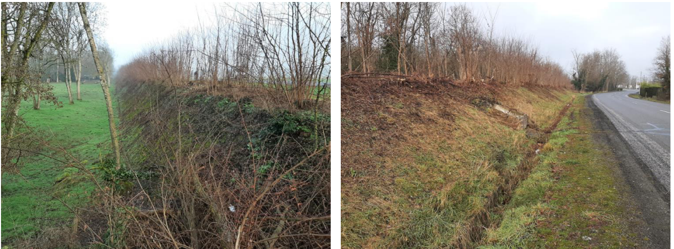
Figure 2 : Vues du tronçon n°1
