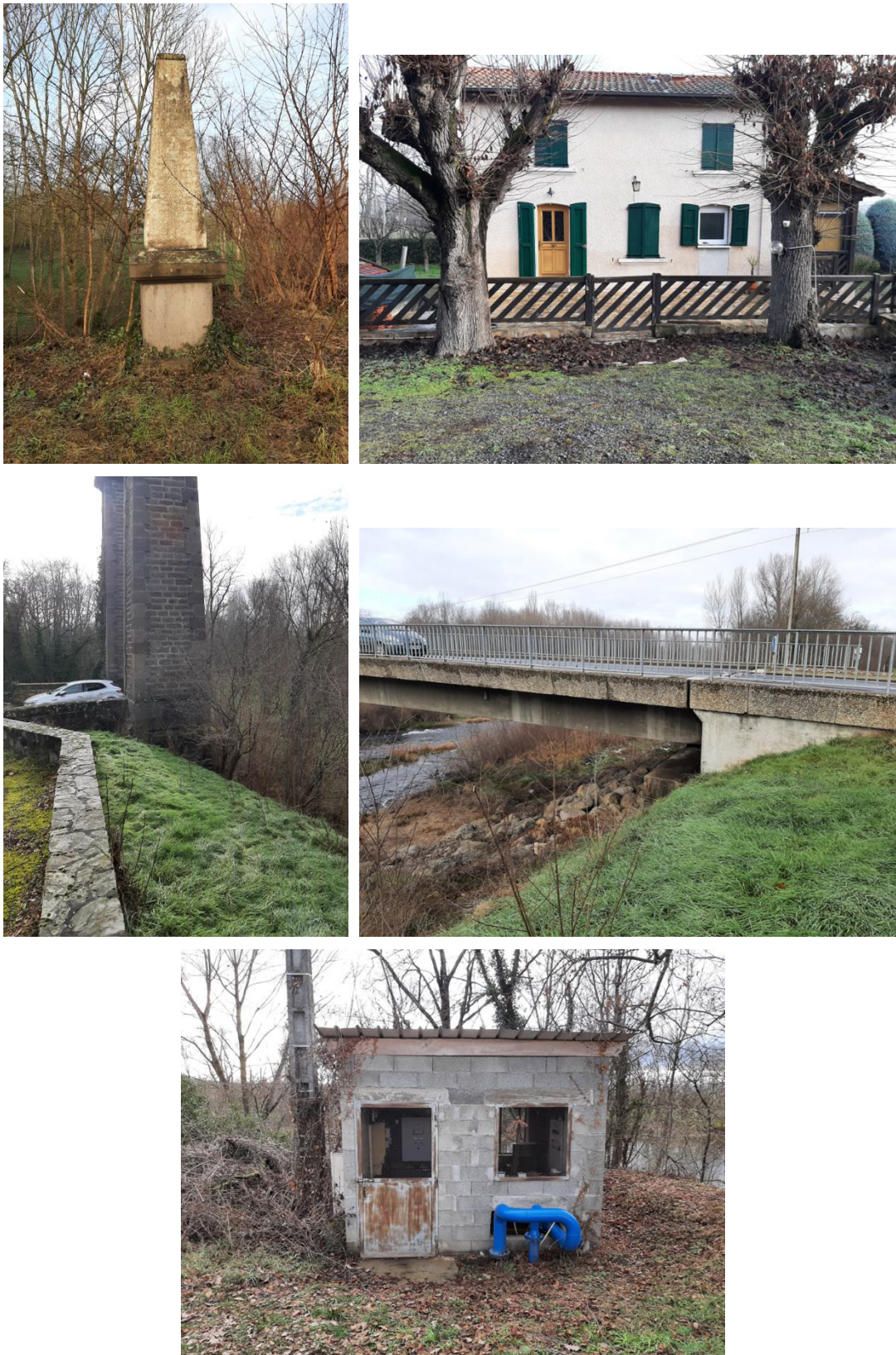
Figure 21 : Eléments présents sur ou à proximité immédiate de l'ouvrage (Observations 2, 14, 18, 19 et 49)
