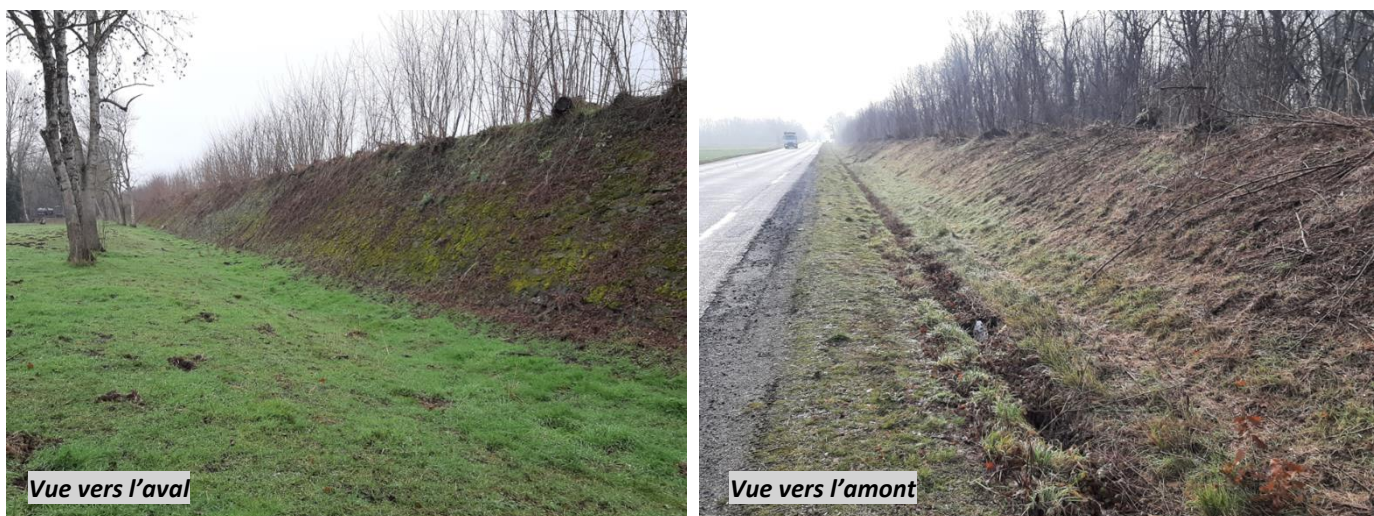
Figure 61 : Vues du système d'endiguement de Lamothe – Tronçon 1 / Section a (T1a)
