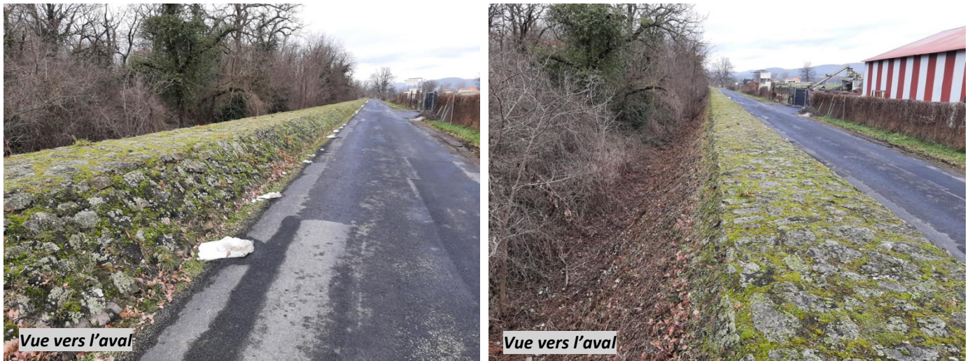
Figure 69 : Vues du système d'endiguement de Lamothe – Tronçon 2 / Section a (T2a)
