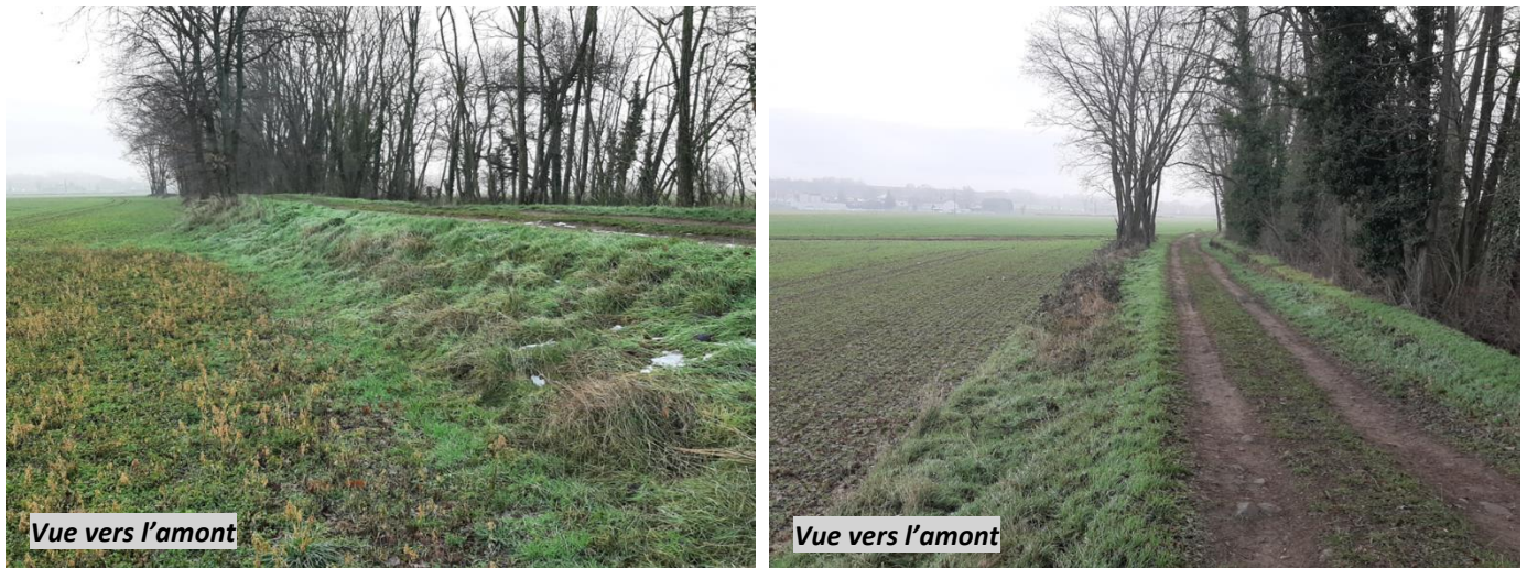
Figure 82 : Vues du merlon en rive droite du Ternivoli
