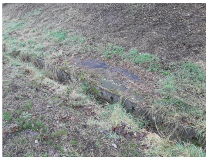
Figure 86 : Regard Telecom et fossé en U en béton au niveau du tronçon T1a
