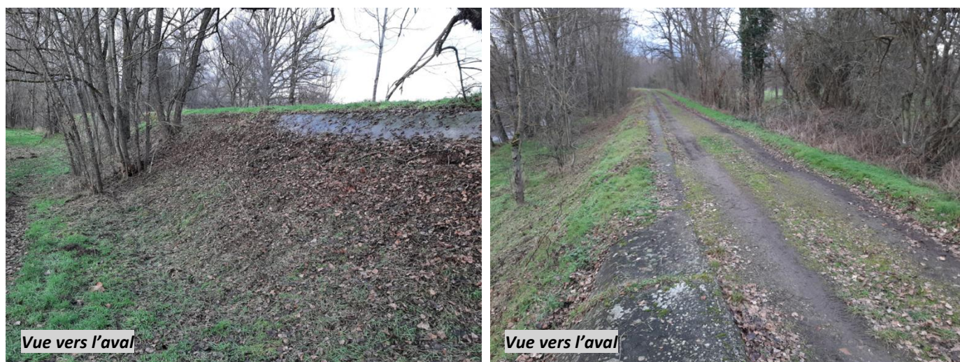
Figure 81 : Vues du système d'endiguement de Lamothe – Tronçon 3 / Section c (T3c)
