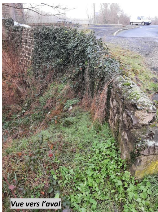
Figure 66 : Vues du système d'endiguement de Lamothe – Tronçon 1 / Section c (T1c)
