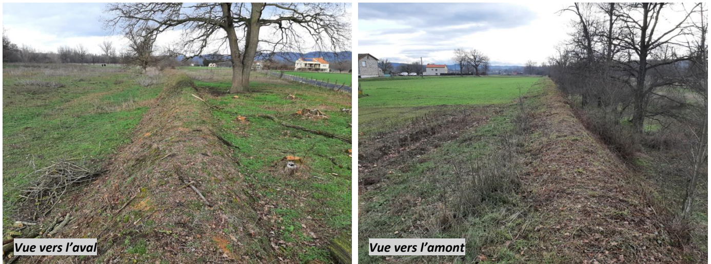
Figure 71 : Vues du système d'endiguement de Lamothe – Tronçon 2 / Section b (T2b)
