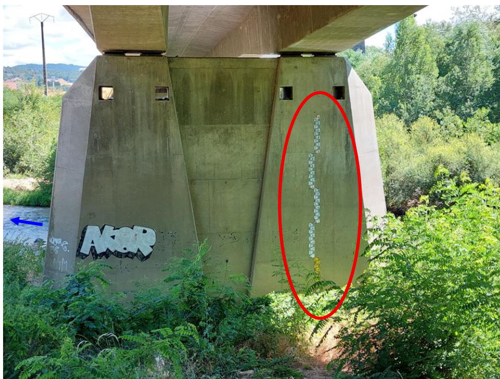
Figure 87 : Echelle limnimétrique présente sur la pile rive gauche du pont de Lamothe
