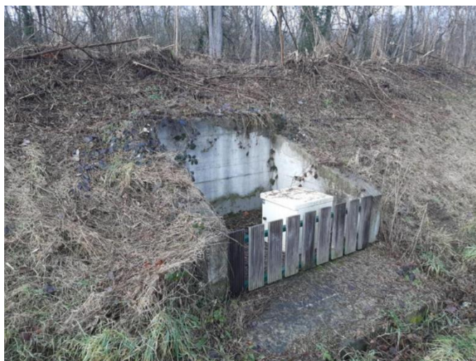
Figure 62 : Ouvrage en béton encastré côté zone protégée
