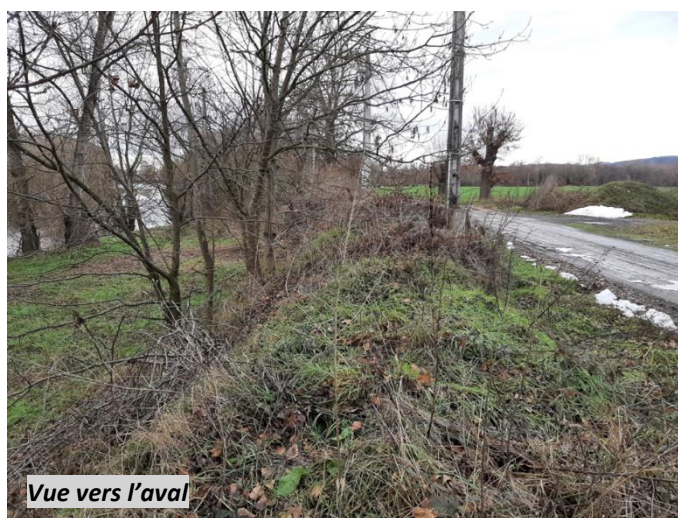
Figure 76 : Vues du système d'endiguement de Lamothe – Tronçon 3 / Section a (T3a)
